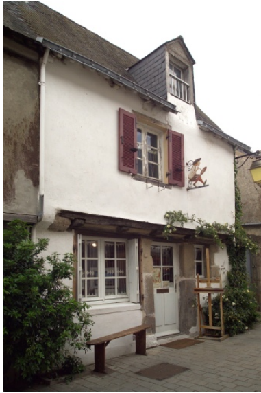
Vue de la façade sur rue. Phot. Denis Pillet IVR52_20064402527NUCA
