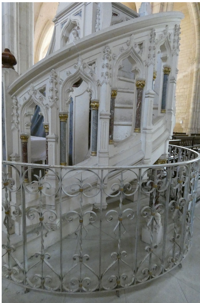
La clôture en ferronnerie et l'escalier.
