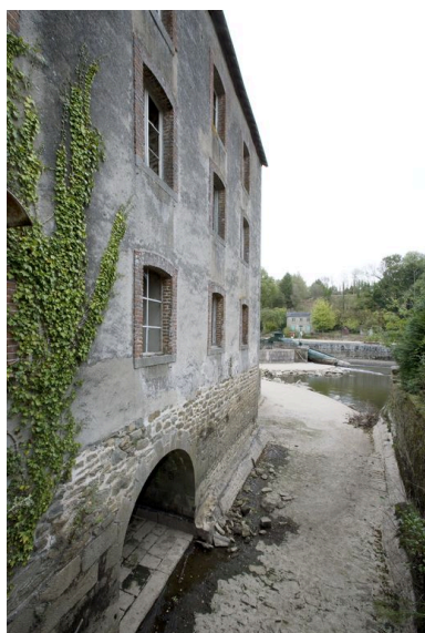
La sortie d'eau est et le canal de fuite pendant les écoures de 2009.
