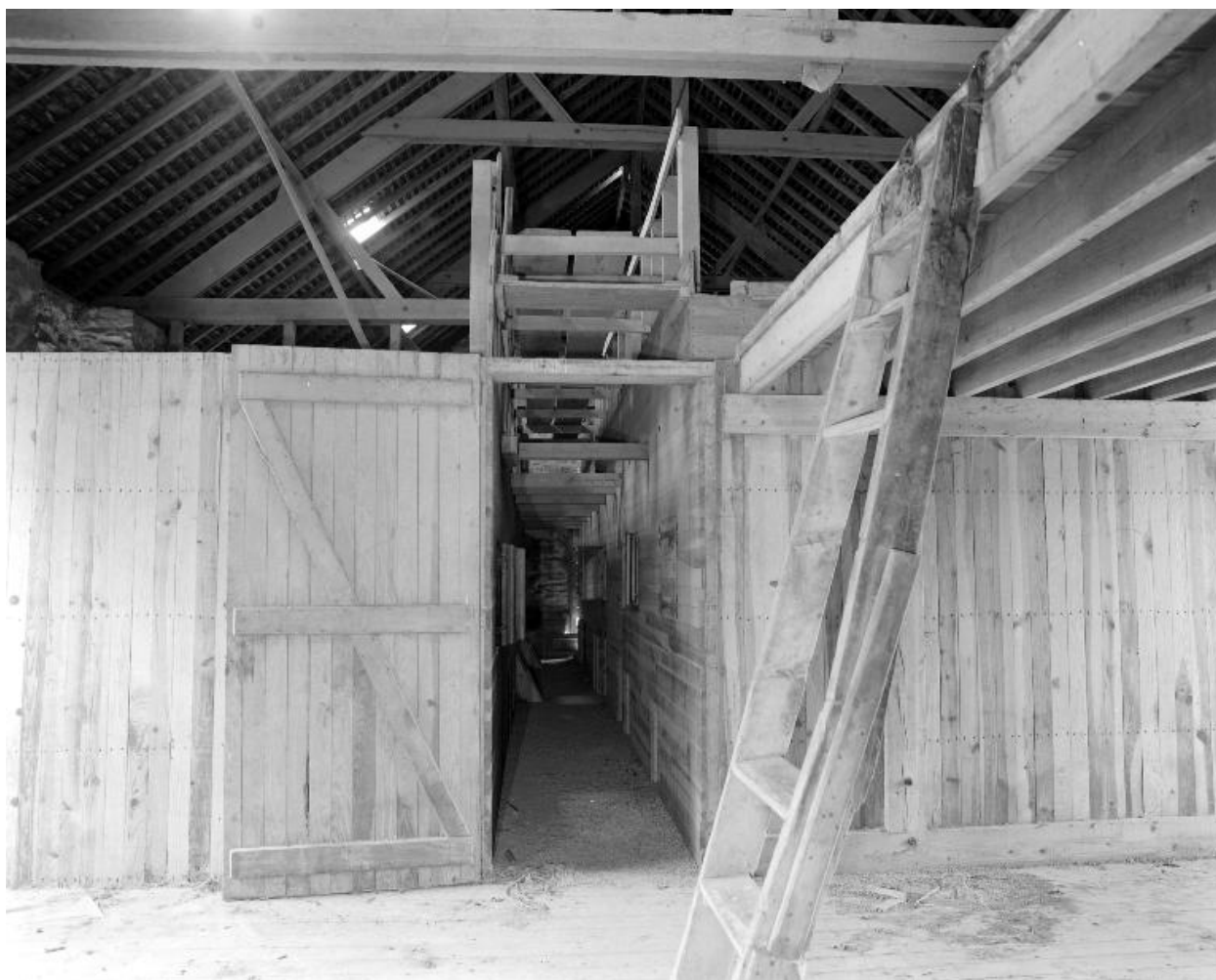
L'étage en surcroît du moulin où sont établies des pièces de stockage desservies par un couloir central.
