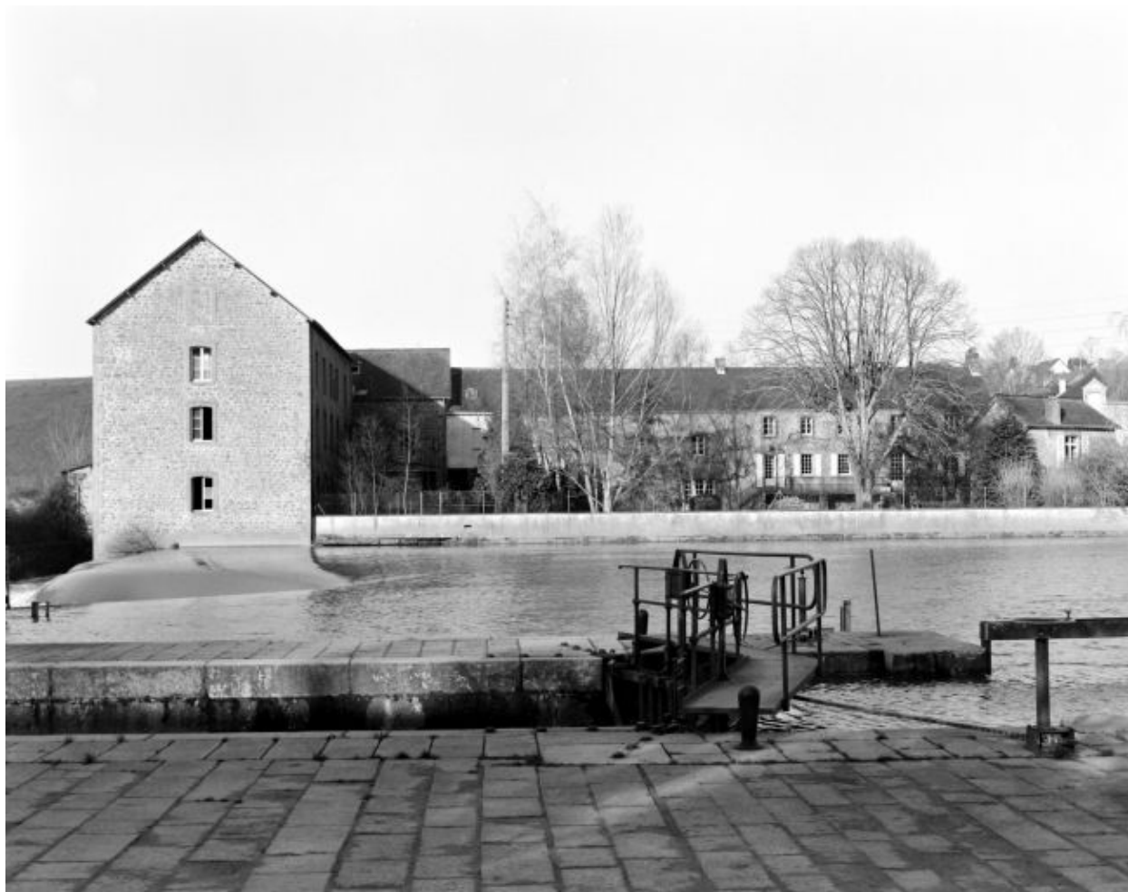
Vue d'ensemble du moulin et de sa principale dépendance depuis la rive gauche : en avant à droite, le pavillon abritant les bureaux.
