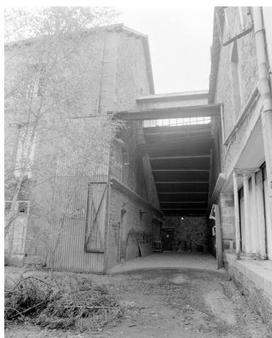
Le passage couvert et la passerelle reliant le moulin (à gauche) au bâtiment servant au stockage des céréales et de la farine (à droite).
