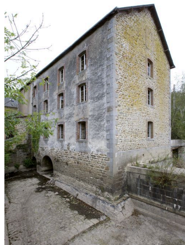
Le moulin vu depuis la plateforme d'aval du barrage, pendant les écoures de 2009.
