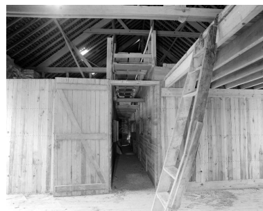
L'étage en surcroît du moulin où sont établies des pièces de stockage desservies par un couloir central. Phot. François Lasa
