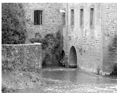
Les deux sorties d'eau et le canal de fuite. Phot. François Lasa IVR52_20025301205X
