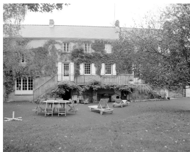
Aile de dépendance du moulin : à gauche de l'escalier, où a été ouverte une porte-fenêtre, l'emplacement du logement d'ouvrier ; à droite sur un soubassement servant de cave et d'étables, l'ancien logement du meunier. Phot. François Lasa IVR52_20015300441X
