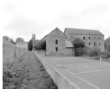
Vue du sud : au fond à gauche, l'ancienne maison du propriétaire, au centre le bâtiment servant au stockage des céréales et de la farine, à droite le moulin. Phot. François Lasa IVR52_20015300439X
