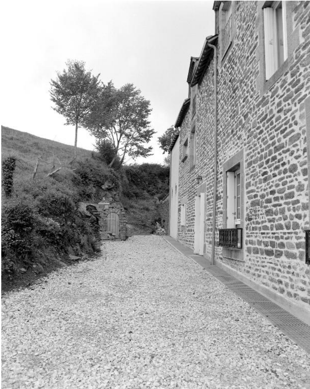
La façade postérieure, au sud, de l'ancienne maison du propriétaire du moulin et le puits.
