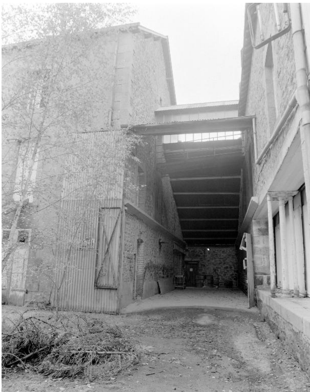
Le passage couvert et la passerelle reliant le moulin (à gauche) au bâtiment servant au stockage des céréales et de la farine (à droite).
