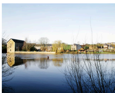
Vue d'ensemble du site du moulin depuis la rive gauche en amont : moulin, dépendance principale en retour, pavillon abritant les bureaux, maison du propriétaire ; à droite, maison réalisée à l'emplacement du poulailler, de la porcherie et de la remise. Phot. François Lasa IVR52_20025300362XA
