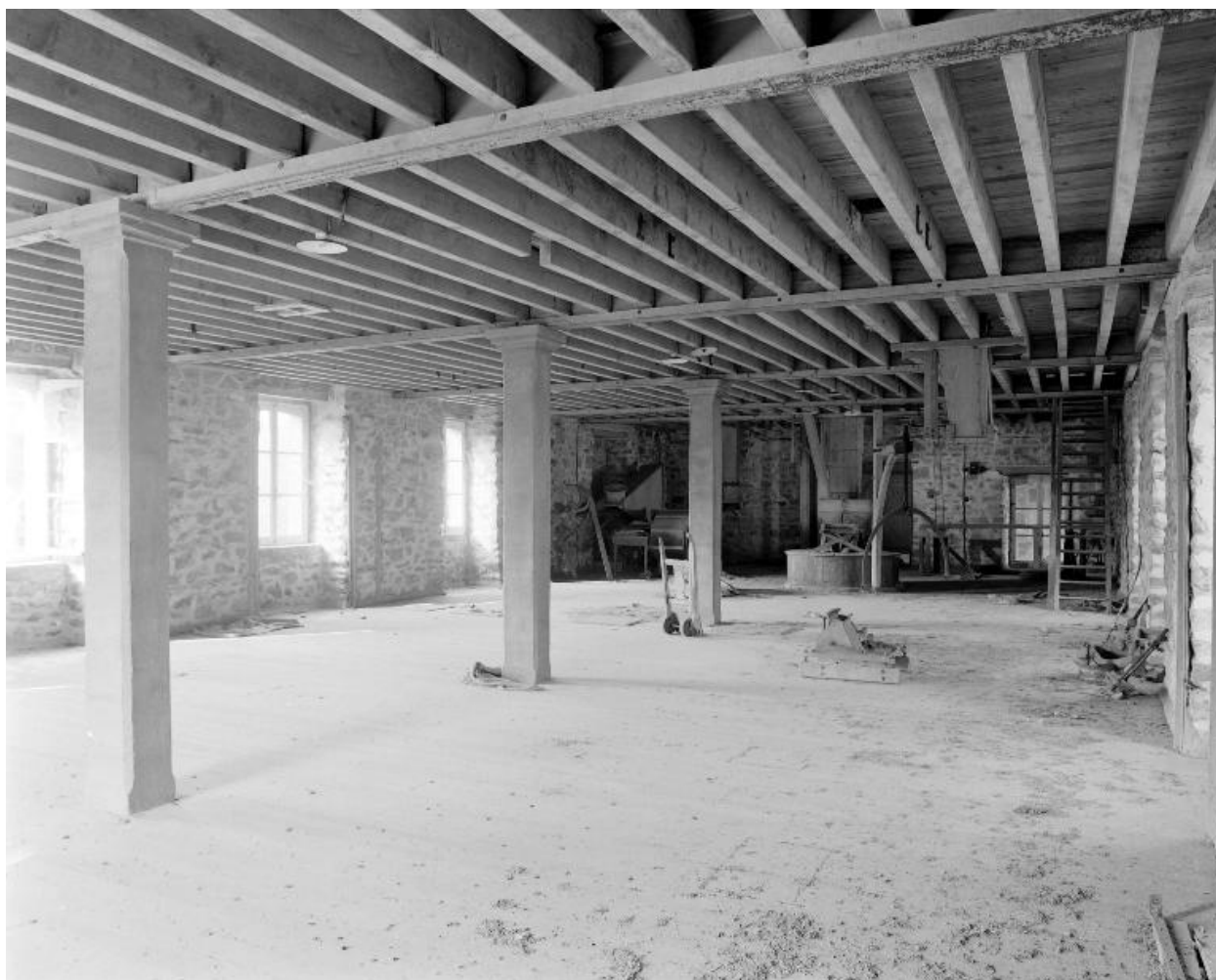
Le premier étage du moulin. Vue vers l'ouest.
