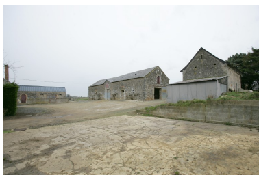
La porcherie, l'étable à vaches- grange et l'écurie vus depuis le sud. Phot. François Lasa IVR52_20075301007NUCA
