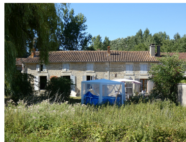
Le logis vu depuis le sud.
