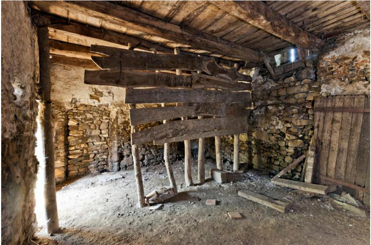
La chapelle, vue intérieure. Partie ouest du rez-de-chaussée, transformée en étable, vue depuis le sud-est : cloison en planches.
