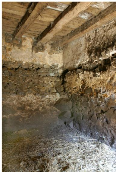
La chapelle, vue intérieure. Partie est du rez-de-chaussée, transformée en étable : angle des murs nord et est avec les traces d'un plancher disparu.
