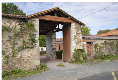
Porte cochère, depuis la route de la Haye-Fouassière. Phot. Pierre-Bernard Fourny IVR52_20224400336NUCA
