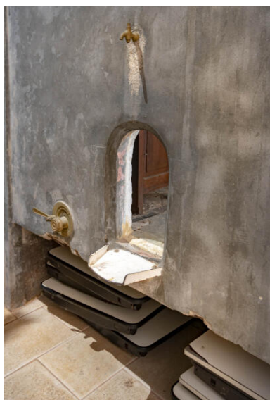
Cuve aérienne désaffectée. Phot. Pierre-Bernard Fourny IVR52_20224400323NUCA
