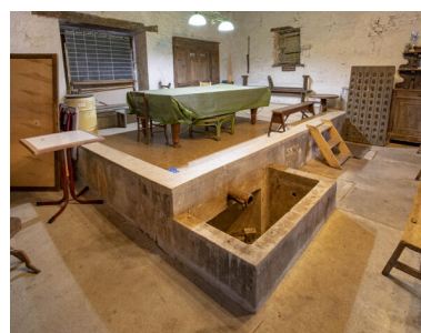
Maie désaffectée et cuves souterraines ; au fond à gauche, porte à vendange. Phot. Pierre-Bernard Fourny IVR52_20224400325NUCA
