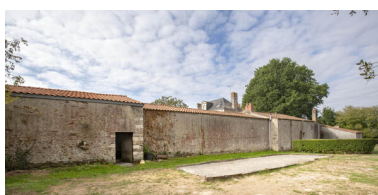
Aile nord de l'ensemble agricole, ayant abrité la cuverie, vue du nord. Phot. Pierre-Bernard Fourny IVR52_20224400324NUCA
