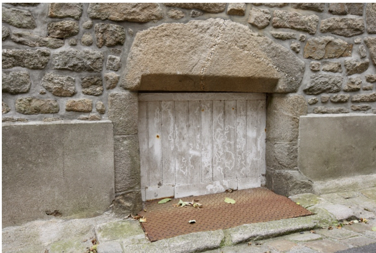
Façade sur rue, détail de l'ouverture donnant dans la cave.
