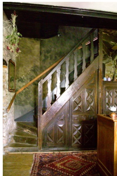
Escalier à balustres en planches sciées et boiserie. Phot. Denis Pillet IVR52_20074400786NUCA
