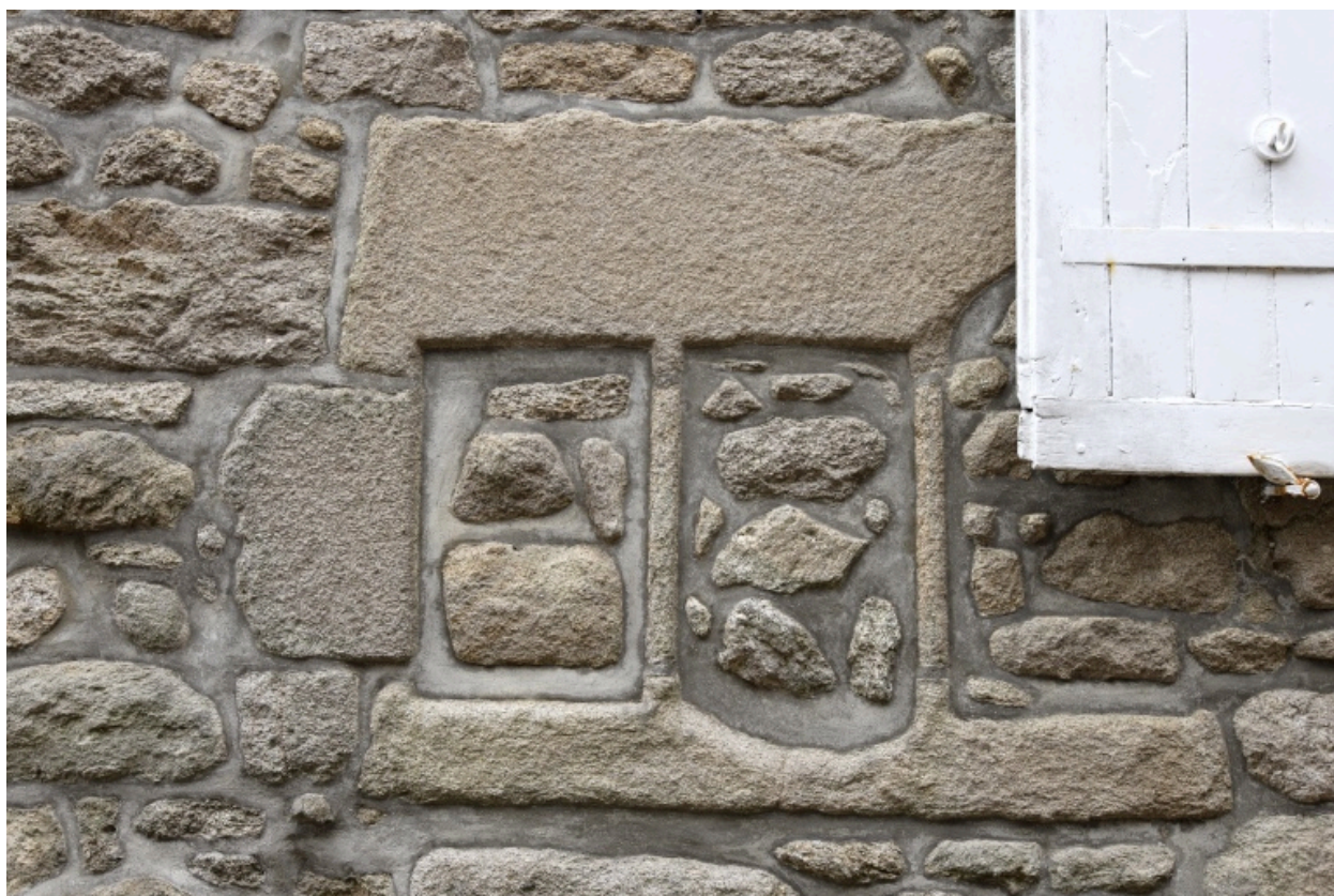
Façade sur rue, détail de la niche murée.
