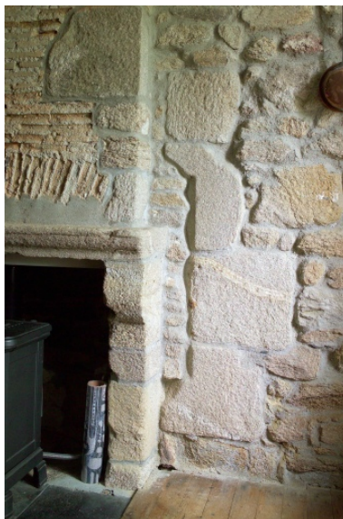
Détail de la cheminée à console et jambage du foyer condamné. Phot. Denis Pillet IVR52_20074400785NUCA
