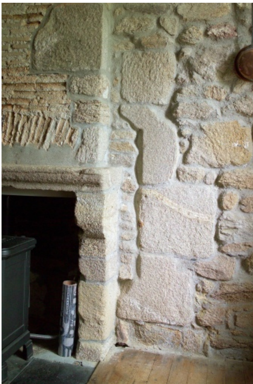
Détail de la cheminée à console et jambage du foyer condamné.
