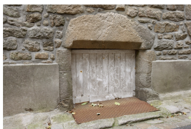
Façade sur rue, détail de l'ouverture donnant dans la cave. Phot. Denis Pillet IVR52_20074401090NUCA
