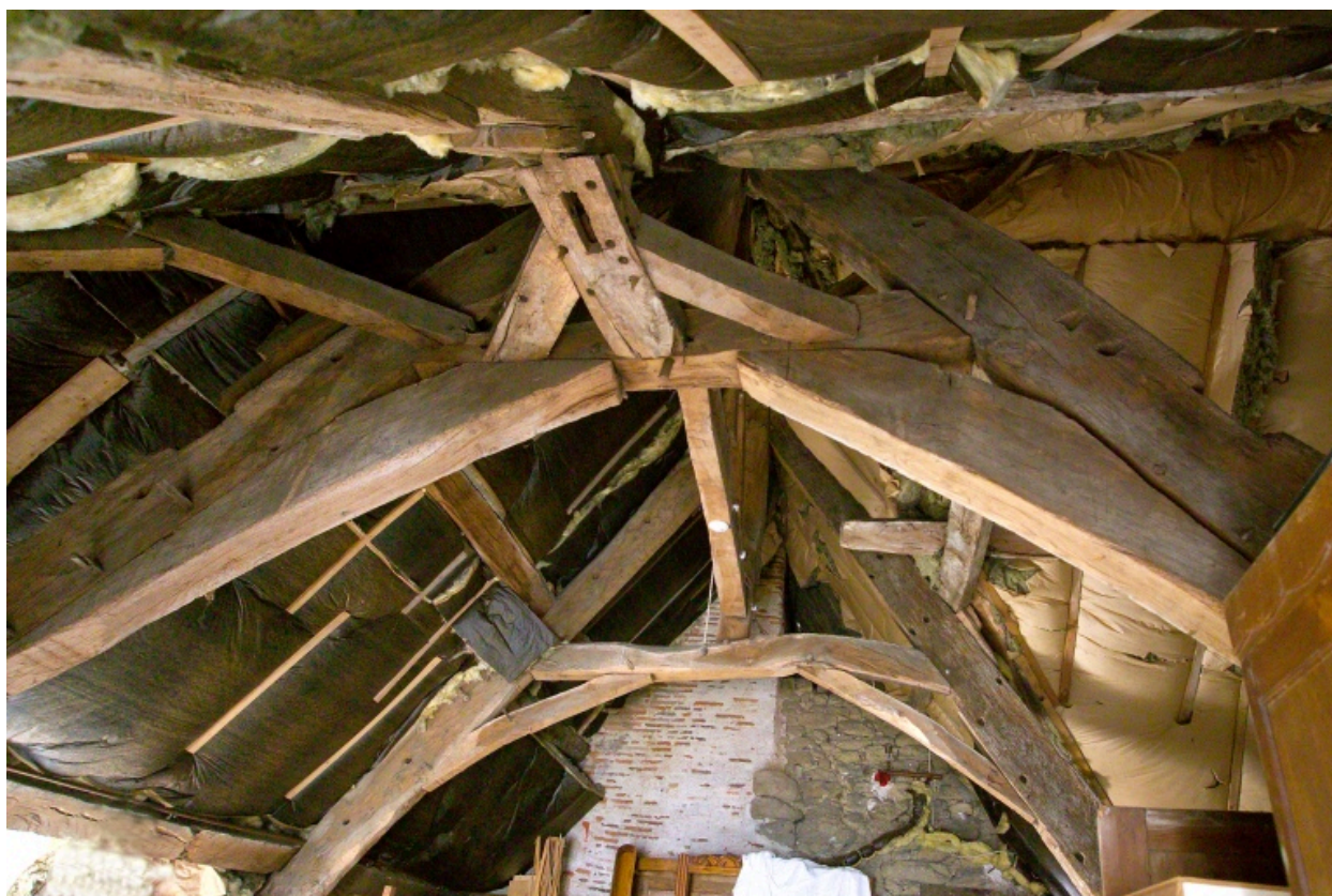
Vue de la charpente vers l'Ouest.
