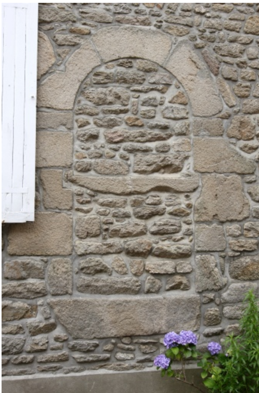
Façade sur rue, détail de la porte murée.
