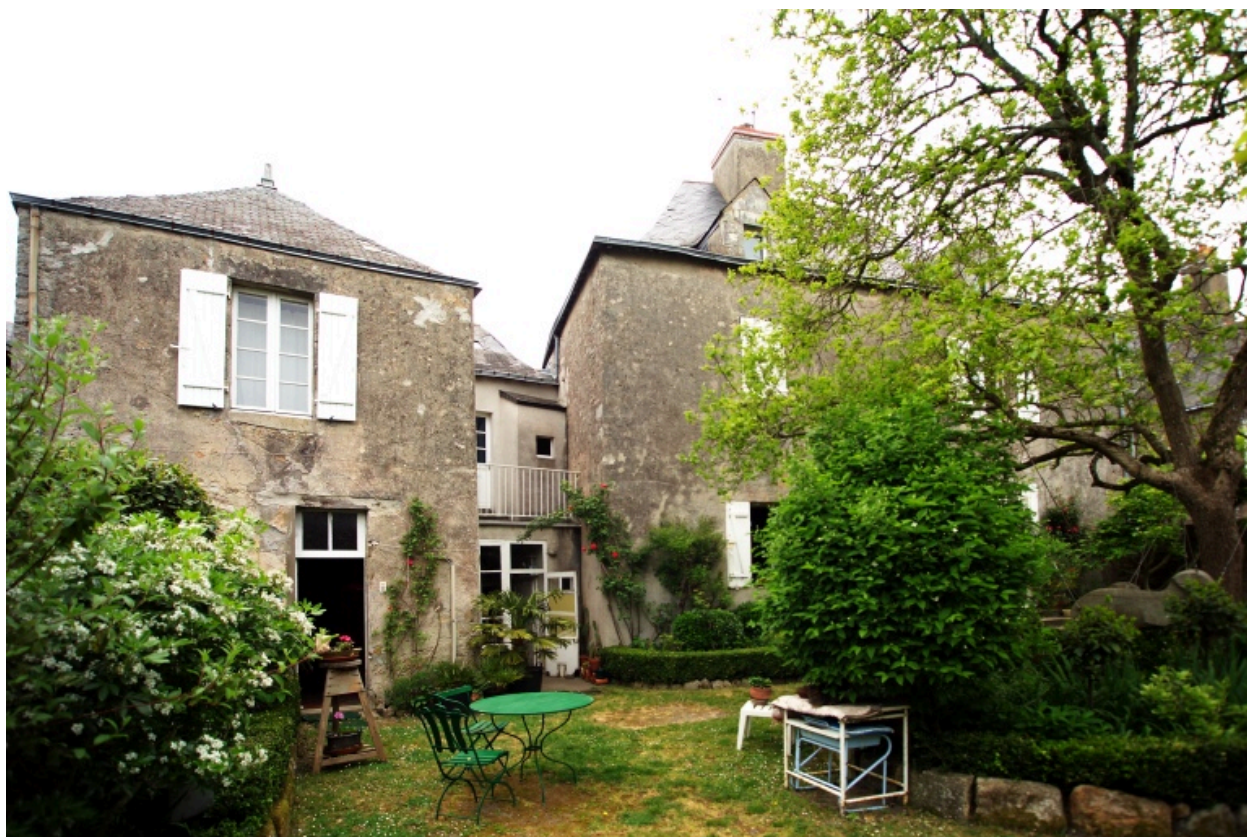
Vue d'ensemble vers le Nord.
