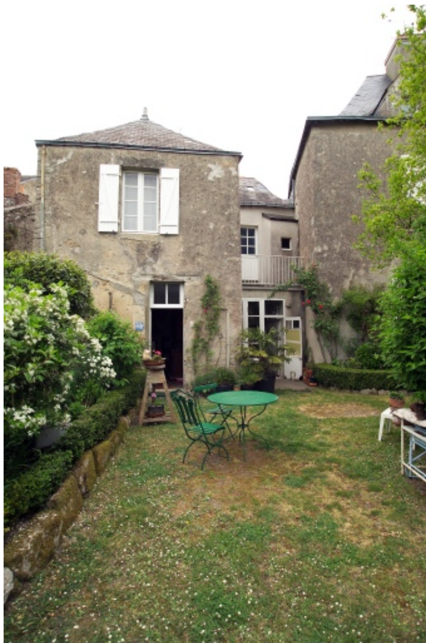
Vue de la petite maison à l'Ouest en fond de cour.
