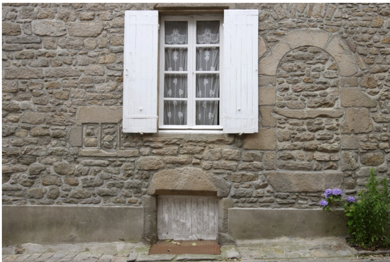
Façade sur rue, détail des ouvertures au rez-de-chaussée.
