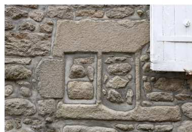
Façade sur rue, détail de la niche murée. Phot. Denis Pillet IVR52_20074401091NUCA
