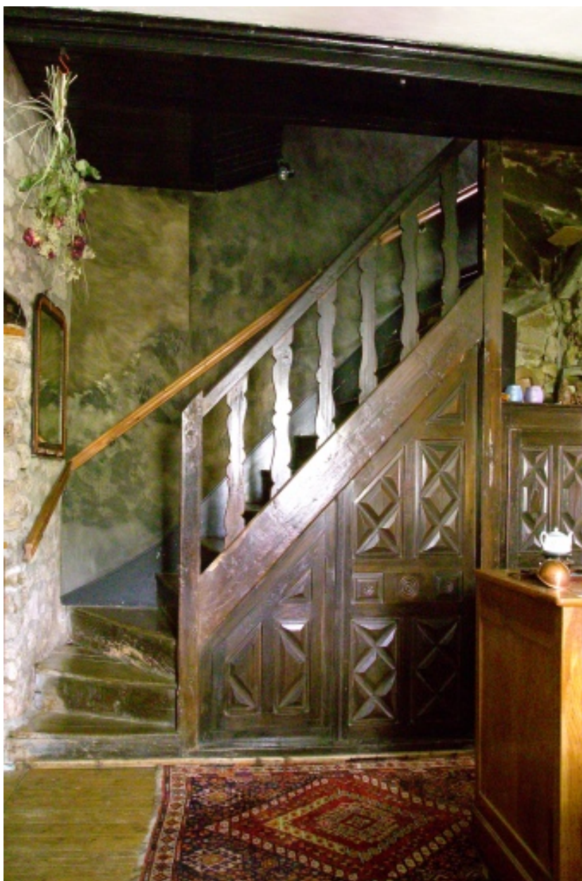
Escalier à balustres en planches sciées et boiserie.
