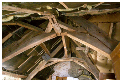
Vue de la charpente vers l'Ouest. Phot. Denis Pillet IVR52_20074400787NUCA
