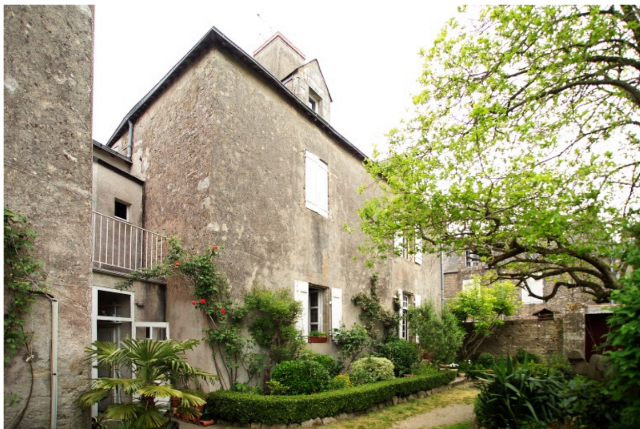
Vue d'ensemble vers l'Ouest.
