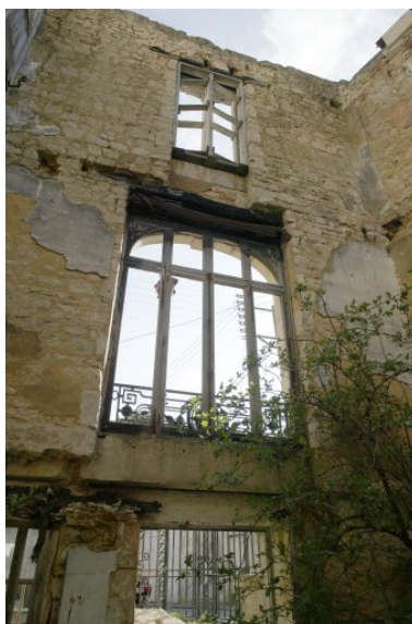
Vue intérieure prise de la cuisine, en direction de la cour d'entrée. Phot. Patrice Giraud IVR52_20078500043NUCA
