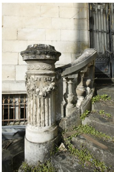
Détail de l'escalier extérieur. Phot. Patrice Giraud IVR52_20078500047NUCA
