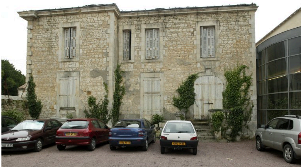
Vue de la façade postérieure prise du nord.
