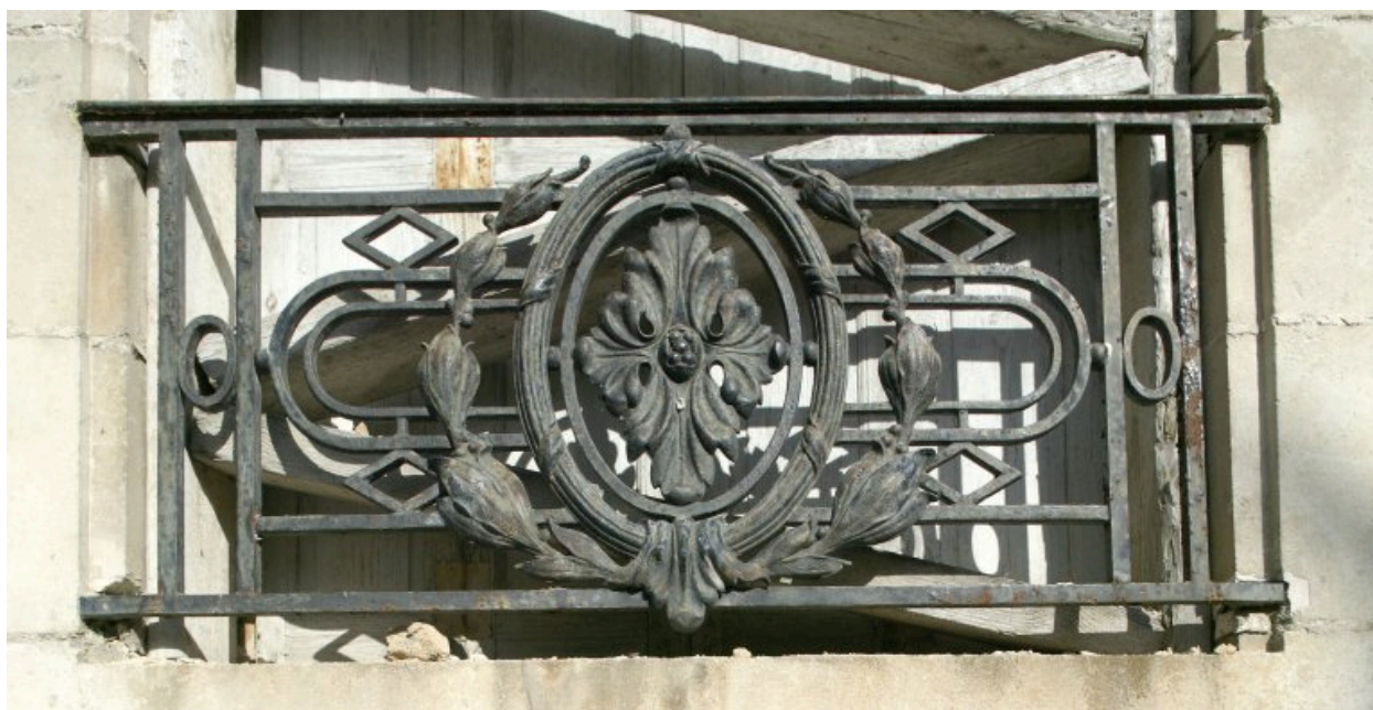
Garde-corps d'une fenêtre, au rez-de-chaussée de la façade rue de l'Hôtel de ville.
