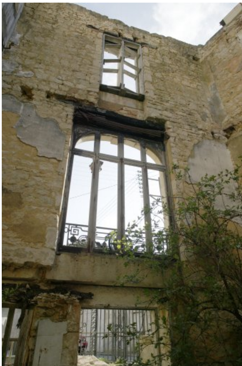
Vue intérieure prise de la cuisine, en direction de la cour d'entrée.
