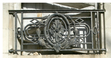
Garde-corps d'une fenêtre, au rez-de-chaussée de la façade rue de l'Hôtel de ville. Phot. Patrice Giraud IVR52_20078500048NUCA
