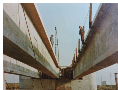
Construction du pont en 1975-1977. Phot. Yannis (reproduction) Suire IVR52_20188501028NUCA
