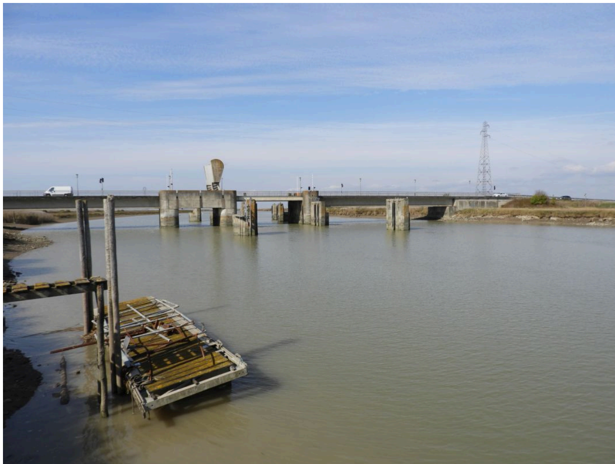
Le pont vu depuis l'est, en amont, avec un appontement.
