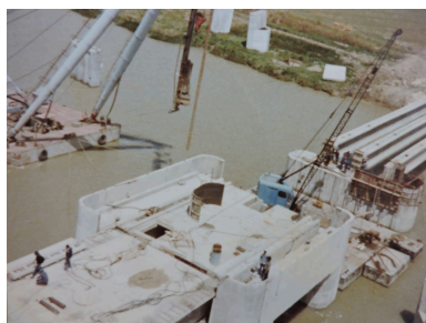
Construction du pont en 1975-1977. Phot. Yannis (reproduction) Suire IVR52_20188501030NUCA
