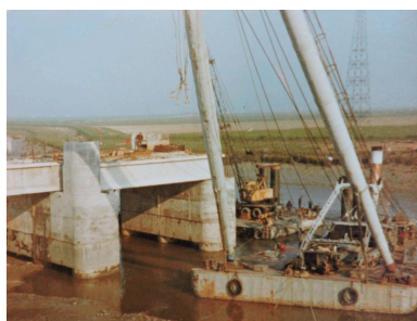
Construction du pont en 1975-1977. Phot. Yannis (reproduction) Suire IVR52_20188501027NUCA
