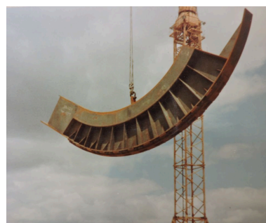
Construction du pont en 1975-1977. Phot. Yannis (reproduction) Suire IVR52_20188501034NUCA
