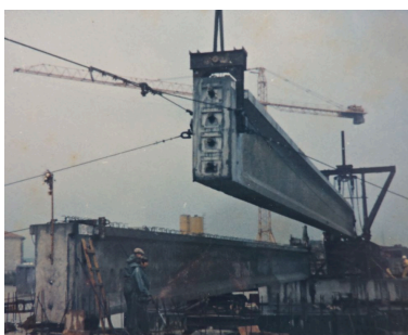
Construction du pont en 1975-1977. Phot. Yannis (reproduction) Suire IVR52_20188501032NUCA
