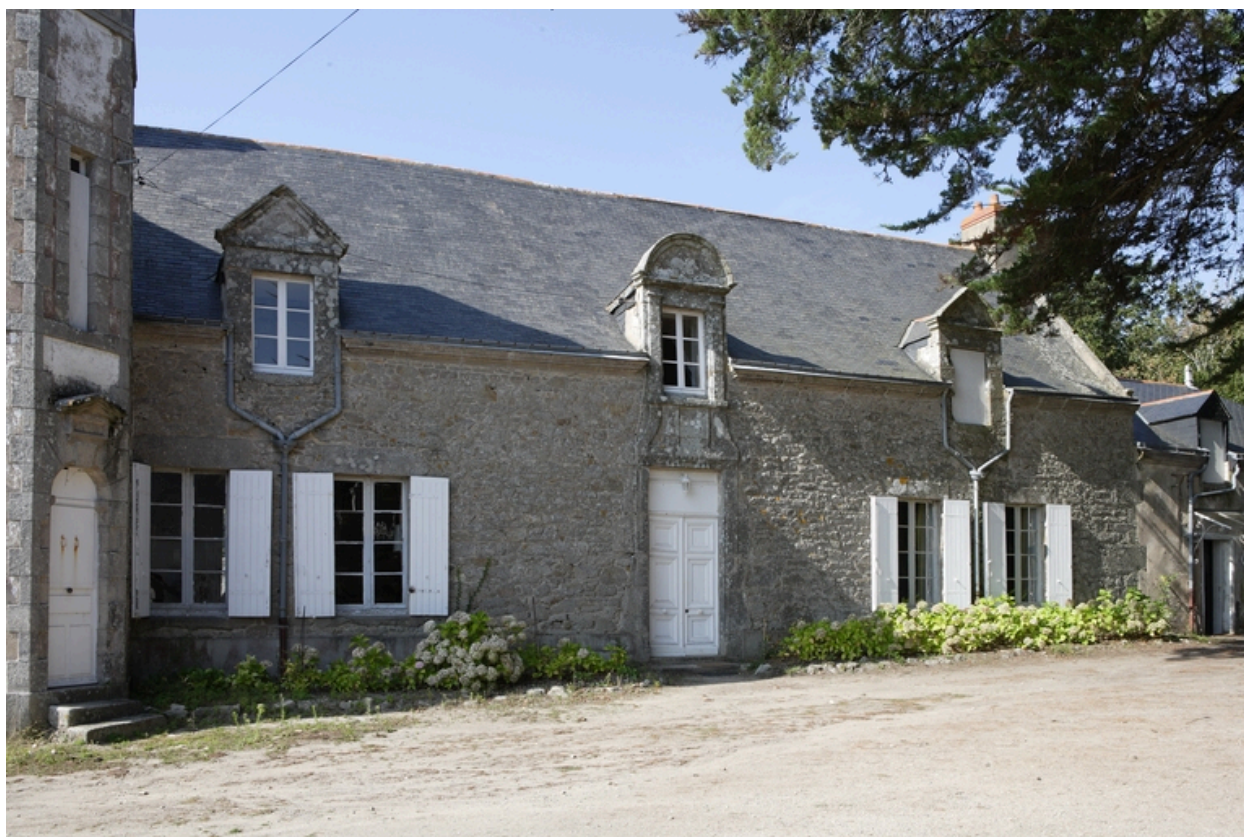
Logis. Façade est.
