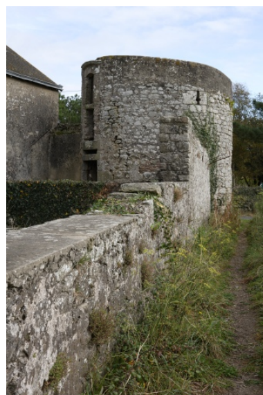
Mur de clôture. Tour d'angle sud-est. Phot. Denis Pillet IVR52_20074401663NUCA
