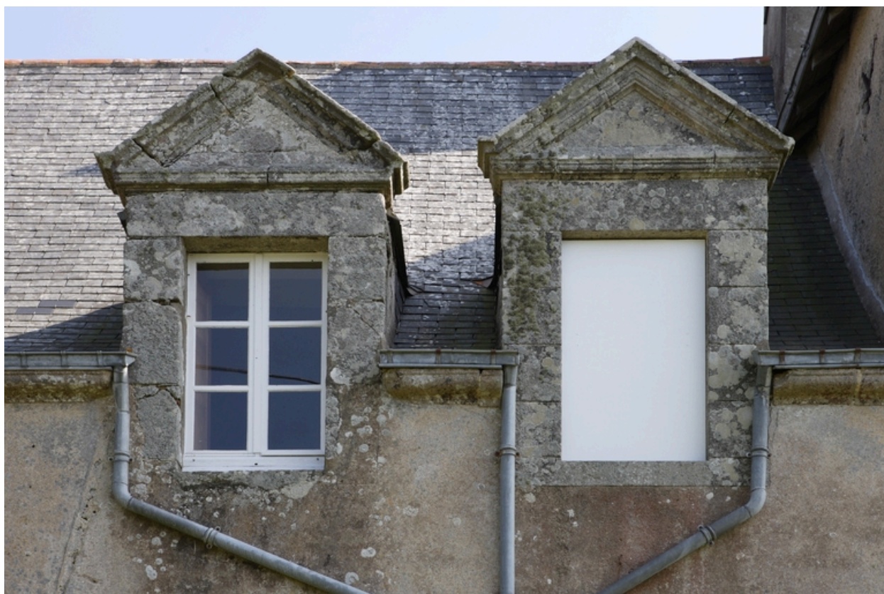
Logis. Façade ouest. Lucarnes (à droite).
