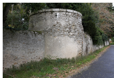
Mur de clôture. Tour est. Phot. Denis Pillet IVR52_20074401666NUCA
