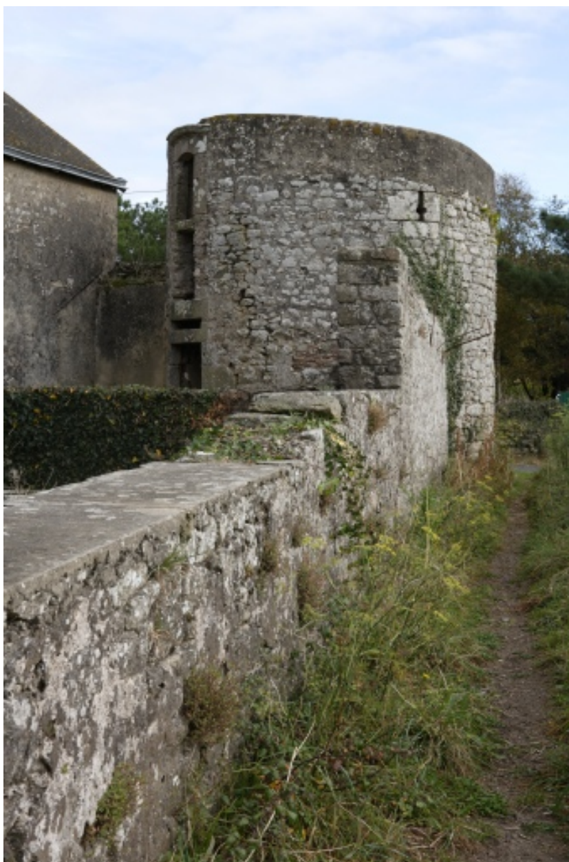
Mur de clôture. Tour d'angle sud-est.
