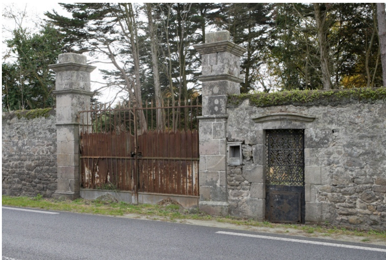
Mur de clôture. Portail d'entrée.
