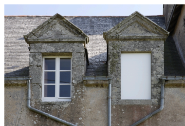
Logis. Façade ouest. Lucarnes (à droite). Phot. Denis Pillet IVR52_20094401256NUCA
