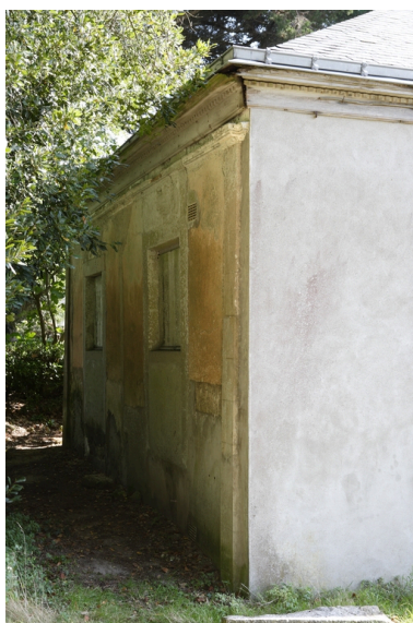
Annexe nord. Angle nord-ouest. Phot. Denis Pillet IVR52_20094401259NUCA
