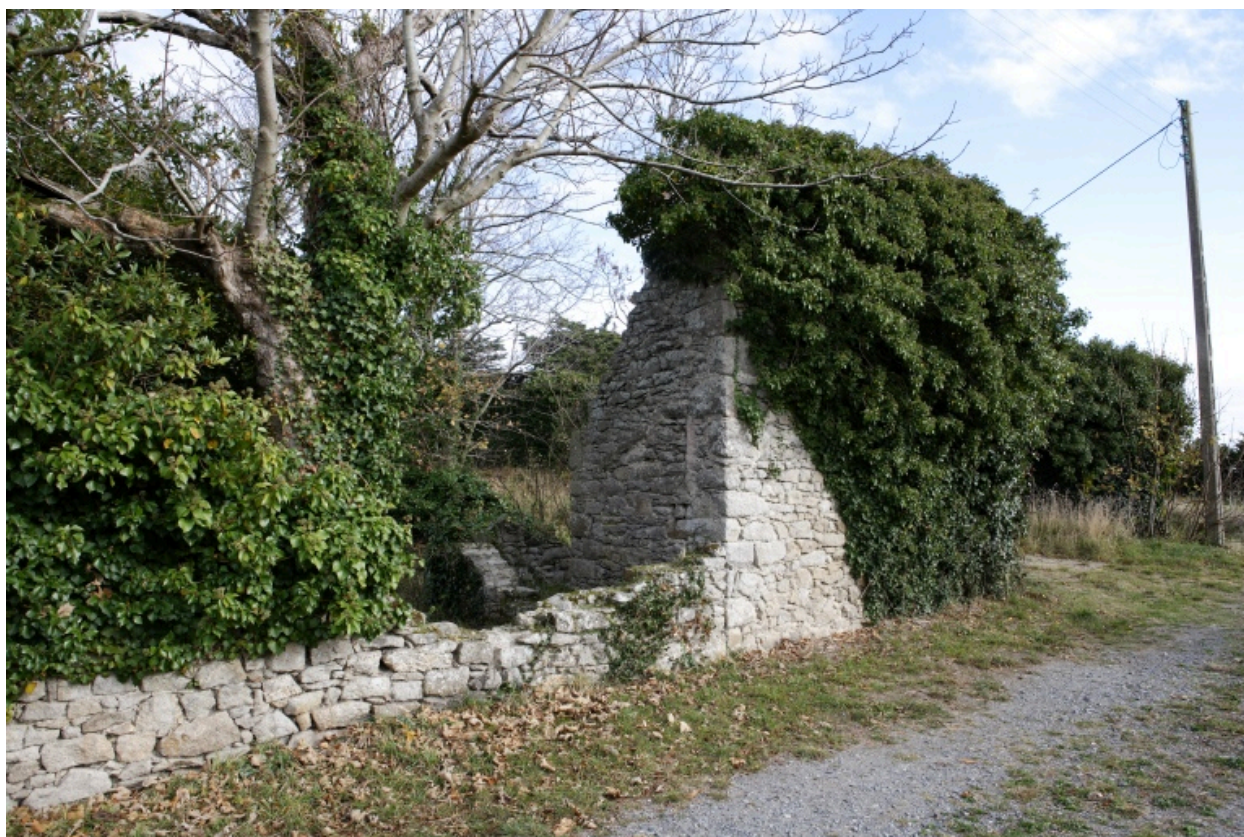
Mur de clôture. Tour d'angle sud-ouest.
