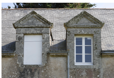
Logis. Façade ouest. Lucarnes (à gauche). Phot. Denis Pillet IVR52_20094401257NUCA
