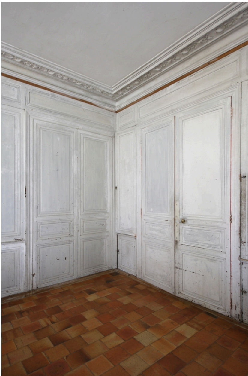
Logis. Détail des boiseries de la salle.
