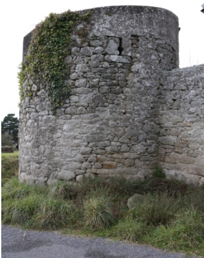
Mur de clôture. Tour d'angle sud-est.
