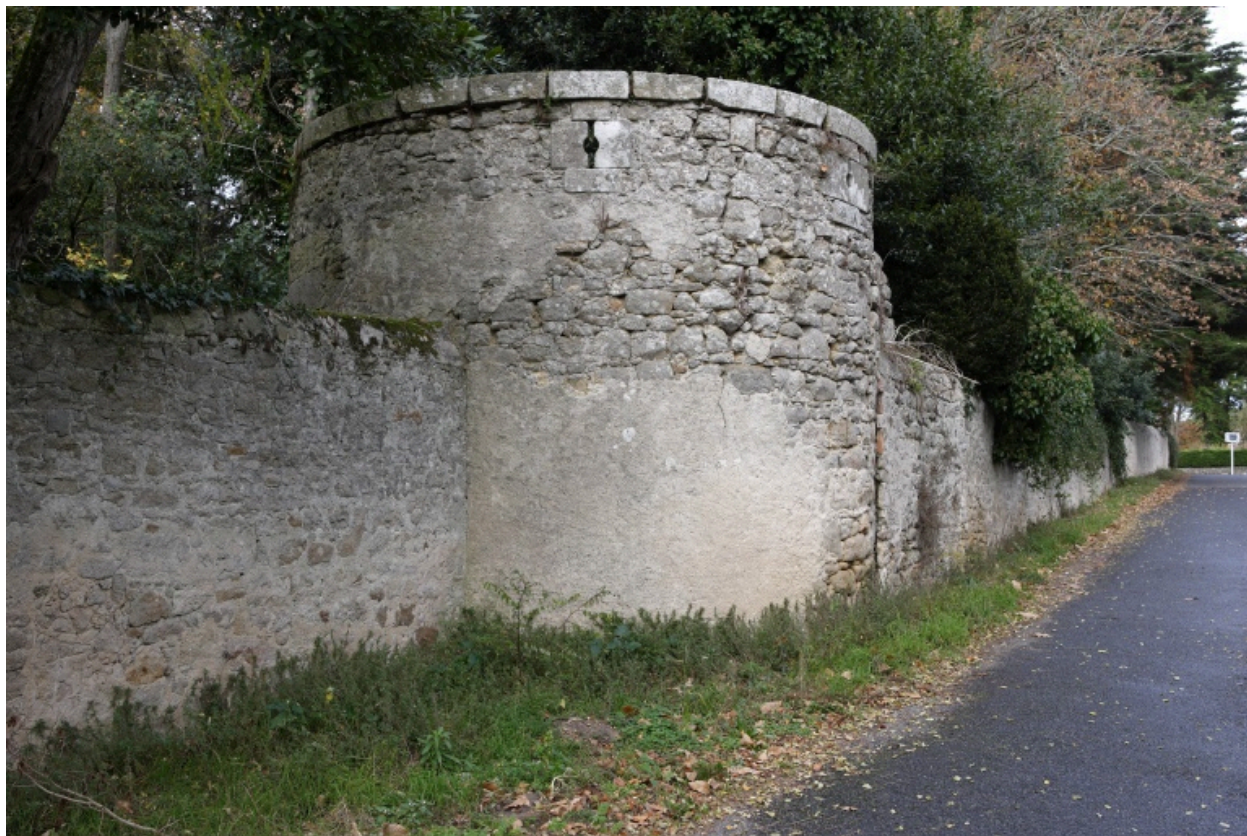
Mur de clôture. Tour est.
