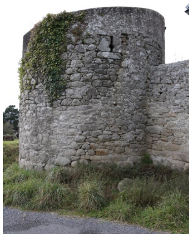
Mur de clôture. Tour d'angle sud-est. Phot. Denis Pillet IVR52_20074401665NUCA
