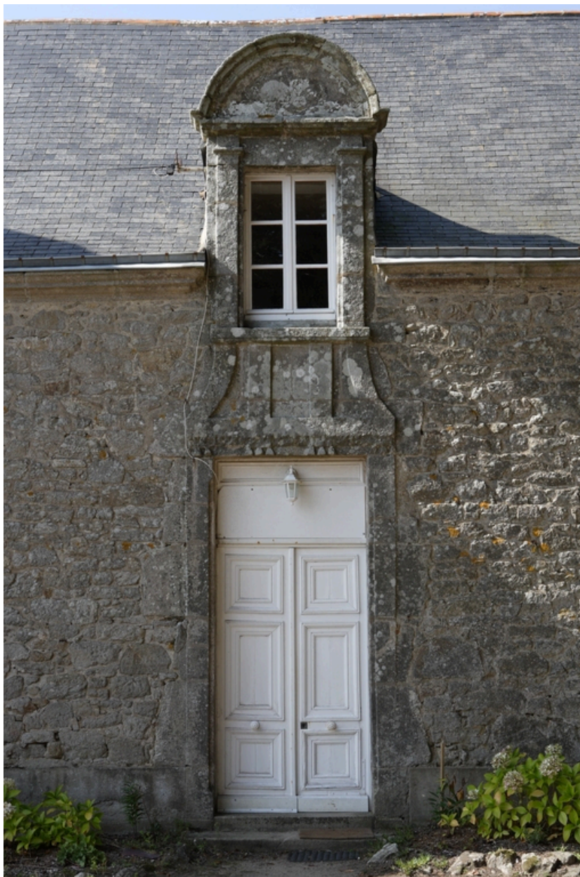
Logis. Façade est. Détail de la travée centrale.
