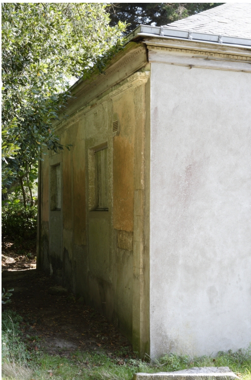
Annexe nord. Angle nord-ouest.
