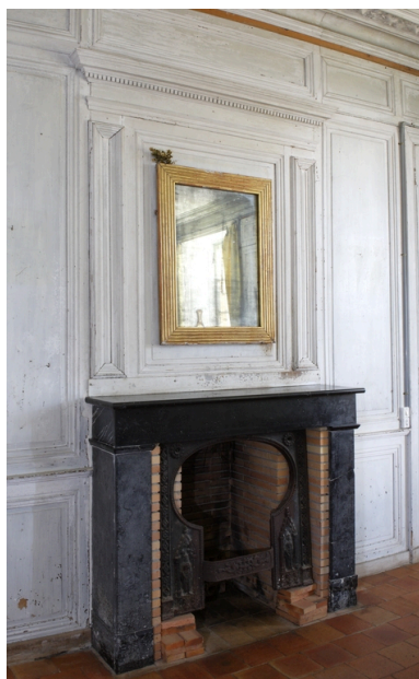
Logis. Cheminée de salle. Phot. Denis Pillet IVR52_20094401251NUCA
