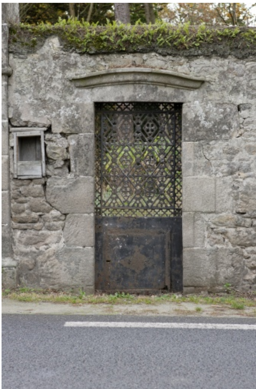
Mur de clôture. Porte piétonnière.
