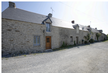
Vue d'ensemble depuis le sud-ouest. Phot. Denis Pillet IVR52_20104401064NUCA
