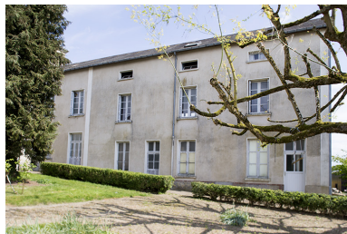
Bâtiment D, élévation sur cour. Phot. Pierre-Bernard Fourny IVR52_20147200137NUCA
