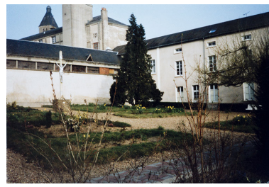
Chapelle et bâtiment D, élévations sur cour. Phot. Pierre-Bernard Fourny IVR52_20137200179NUCA
