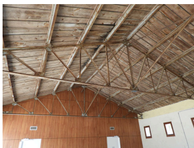
La charpente métallique du préau sur le côté est de la cour.
