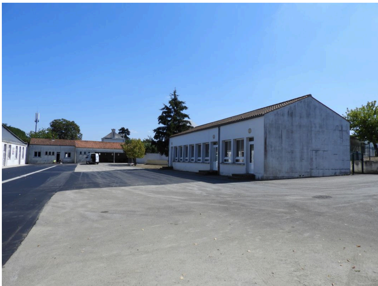
La cour vue depuis l'ouest avec à droite, au sud, l'ancienne cuisine-réfectoire construite en 1964.
