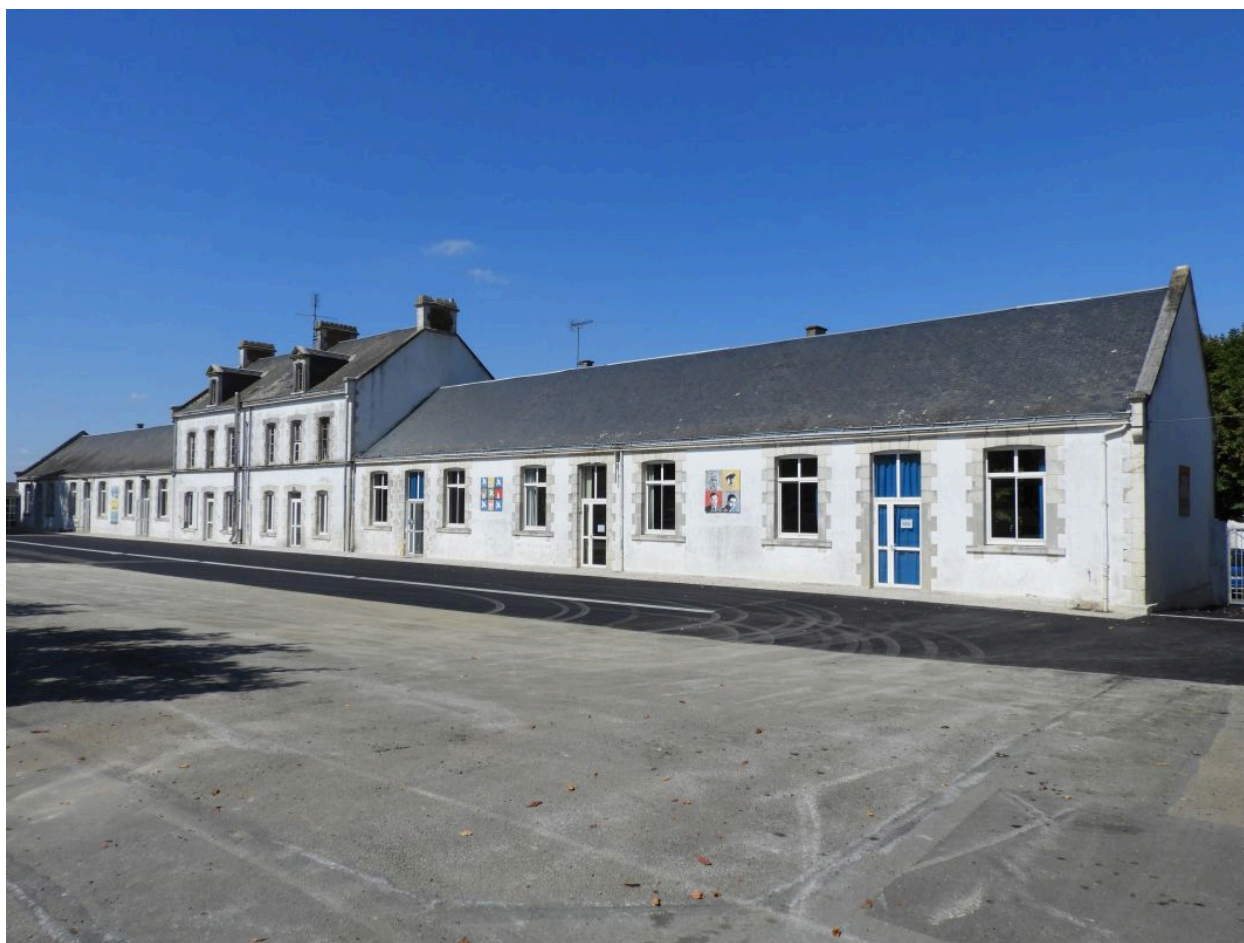
Les bâtiments de la fin du 19e siècle, côté cour, vus depuis le sud-est.
