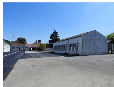
La cour vue depuis l'ouest avec à droite, au sud, l'ancienne cuisine-réfectoire construite en 1964.
