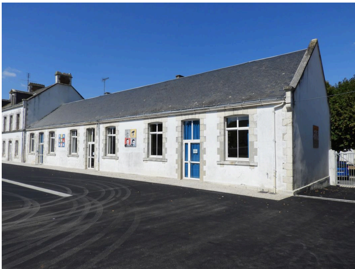
L'aile est de salles de classe vue depuis le sud-est, côté cour.
