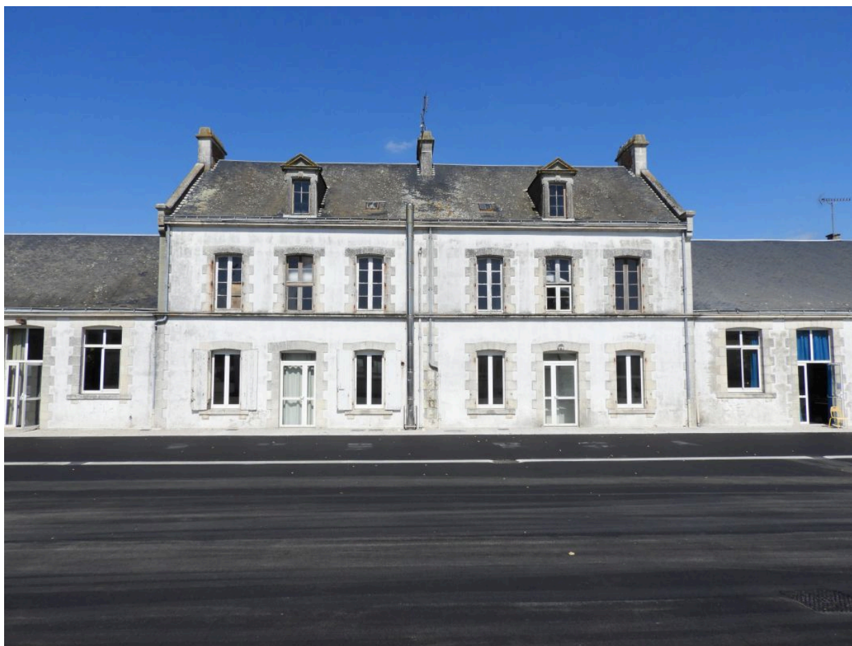
Le corps central de bâtiment, composé symétriquement de deux ensembles de logements, vu depuis le sud, côté cour.
