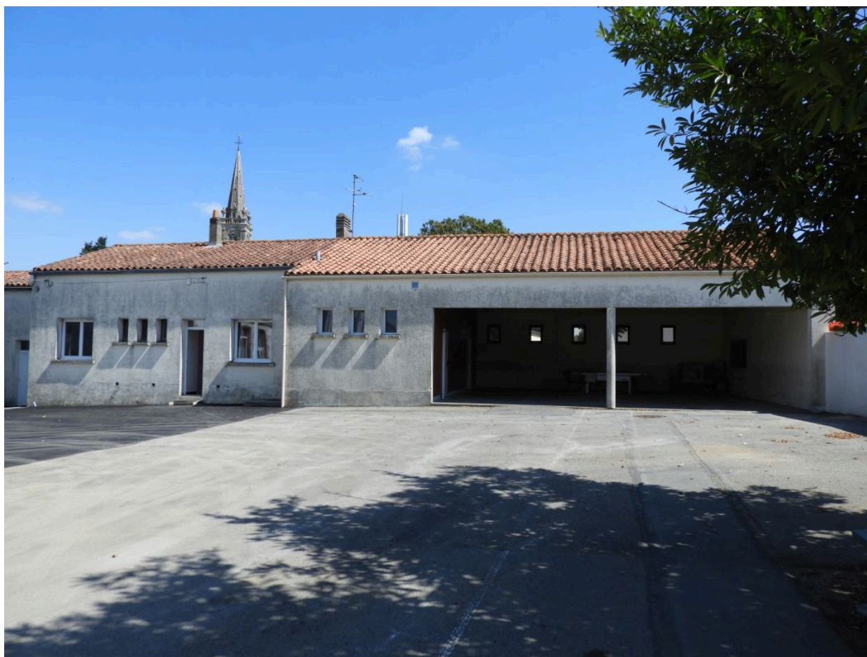
Le logement et le préau construits en 1964 sur le côté est de la cour, vus depuis l'ouest.
