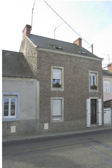
Vue depuis la rue. Phot. François Lasa IVR52_20045303117NUCA
