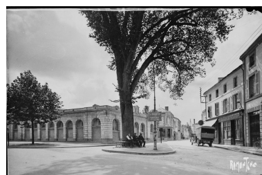
Le minage vu du sud-est. Carte postale du 2e quart du XXe siècle. Autr. Raymond Bergevin IVR52_20108500052NUCA
