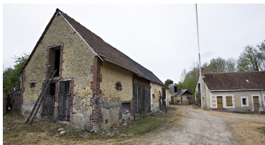
Vue d'ensemble de la ferme. Phot. Pierre-Bernard Fourny IVR52_20147200239NUCA
