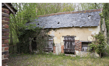
Toit à porcs à l'arrière du logis. Phot. Pierre-Bernard Fourny IVR52_20147200243NUCA
