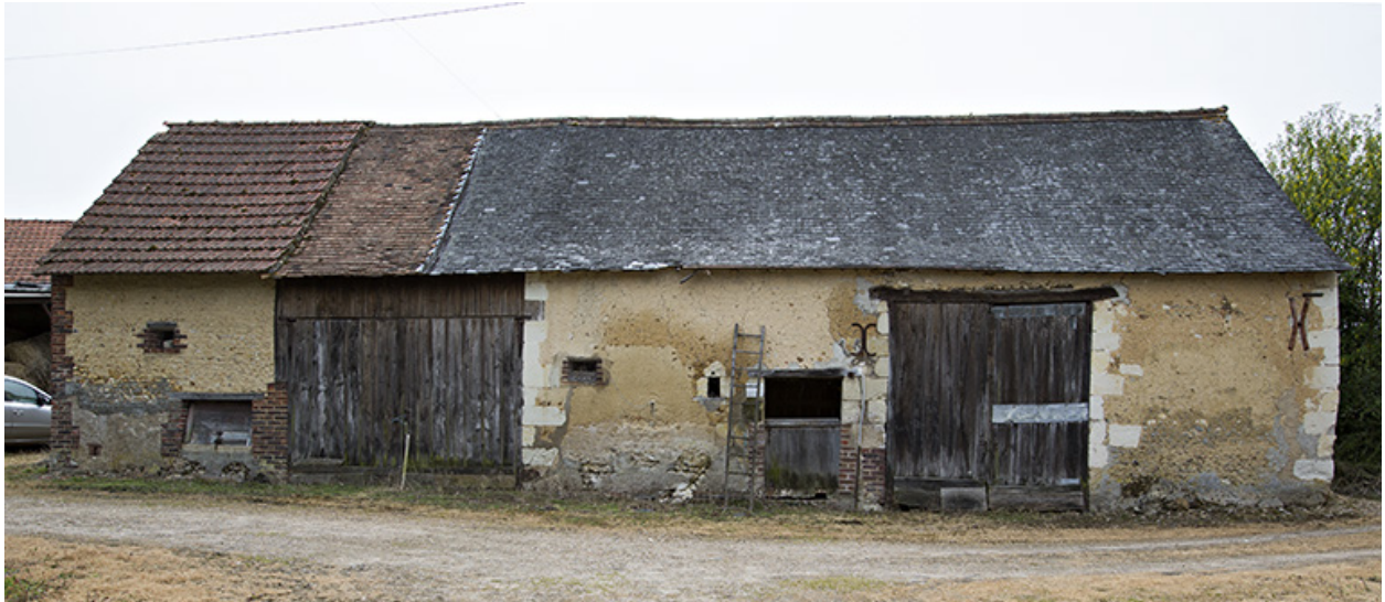
Grange-étable en retour d'équerre disjoint du logis.
