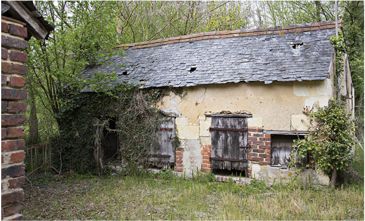
Toit à porcs à l'arrière du logis.
