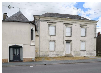
Vue de la façade principale. Phot. Armelle Maugin IVR52_20254900636NUCA
