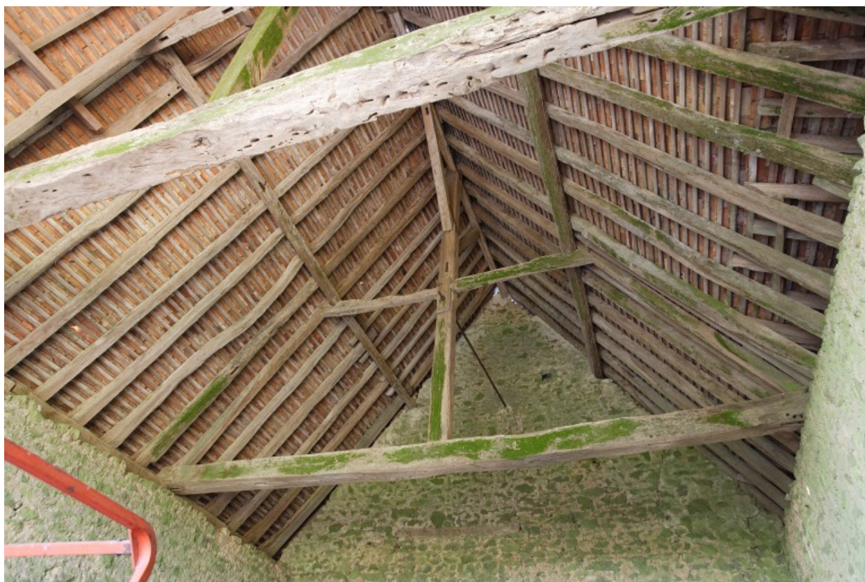
La charpente de la remise.
