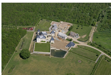
Vue aérienne d'ensemble depuis le sud-ouest. Phot. François Lasa IVR52_20075301924NUCA
