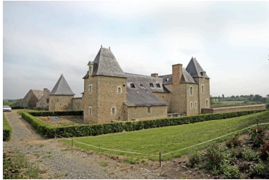
Le manoir vu depuis le nord- ouest : la façade postérieure et le pavillon nord-est. Phot. François Lasa IVR52_20075302221NUCA
