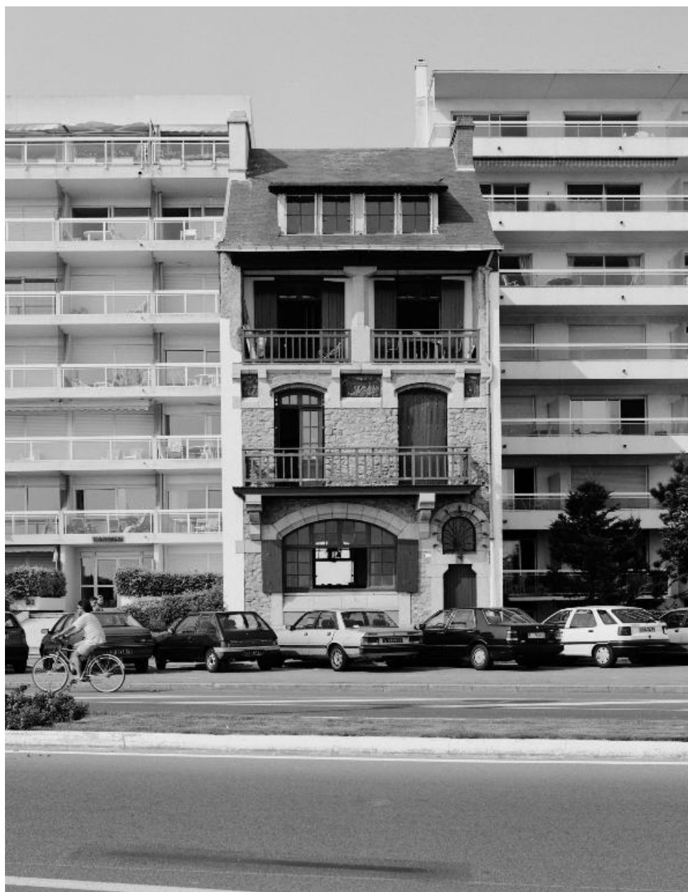
Vue générale de la villa Ker Beji, boulevard Hennecart.
