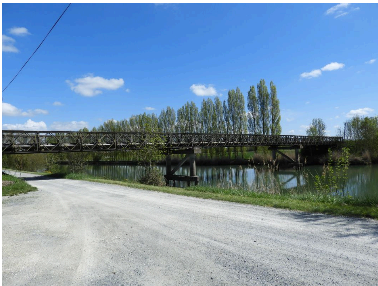
Le pont vu depuis l'ouest.
