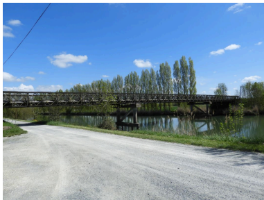
Le pont vu depuis l'ouest. Phot. Yannis Suire IVR52_20198503168NUCA
