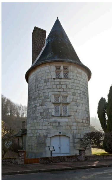
Tour vue depuis l'ouest. Phot. Yves Guillotin IVR52_20127200269NUCA
