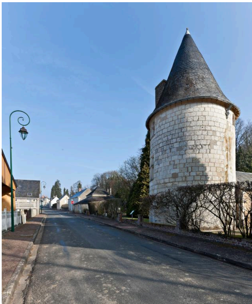
Tour vue depuis le sud.
