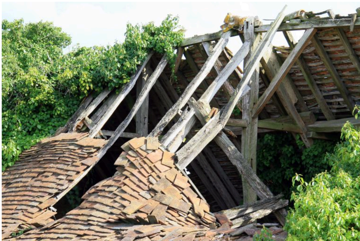
La vieille maison : charpente à pannes.
