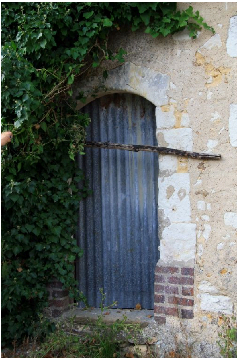
La vieille maison : porte d'entrée en anse de panier.
