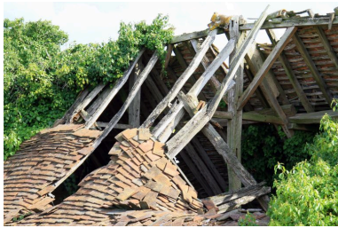
La vieille maison : charpente à pannes. Phot. Jean-Baptiste Darrasse IVR52_20087202066NUCA
