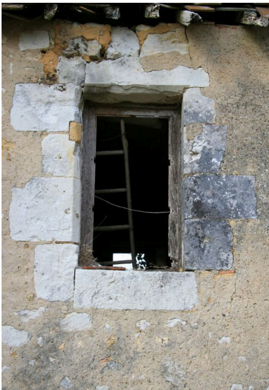
La vieille maison : demi-baie de la chambre à feu.
