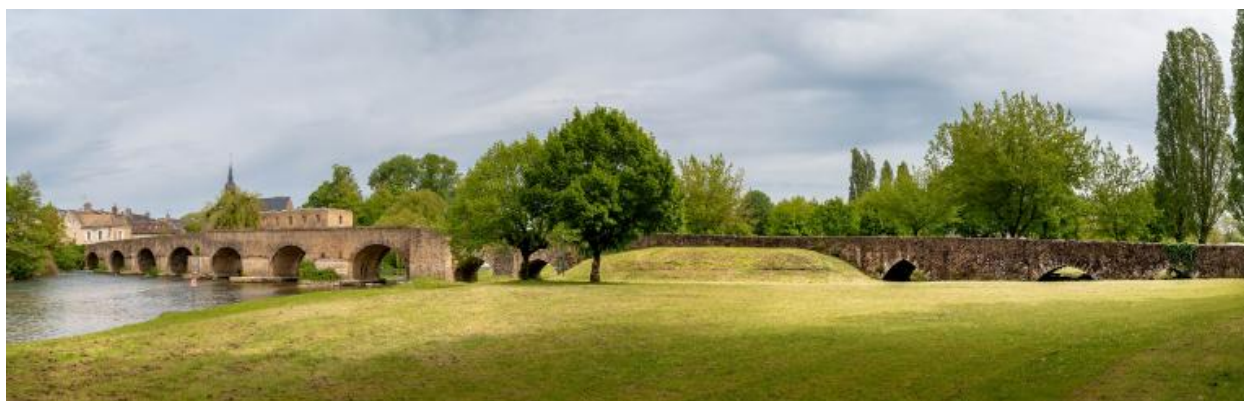
Le pont, face sud.
