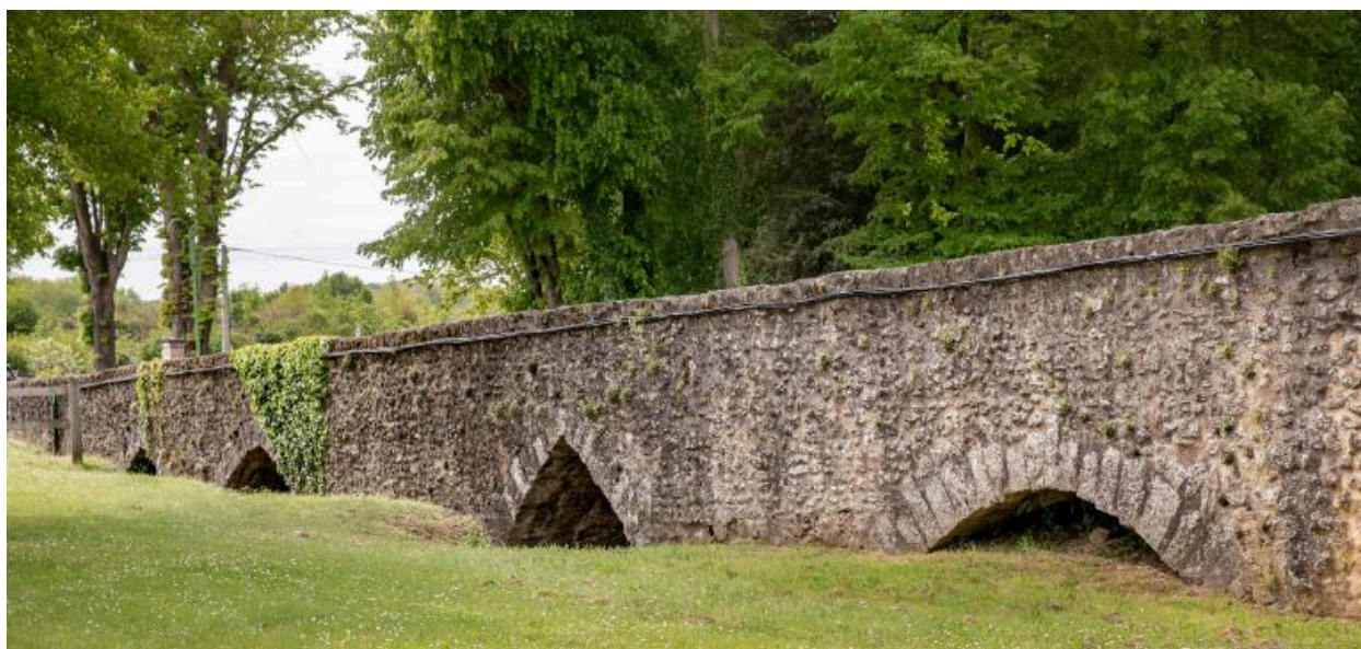
Le pont, face nord, les arches semi-enterrées.
