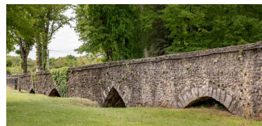
Le pont, face nord, les arches semi-enterrées. Phot. Pierre-Bernard Fourny IVR52_20197200952NUCA
