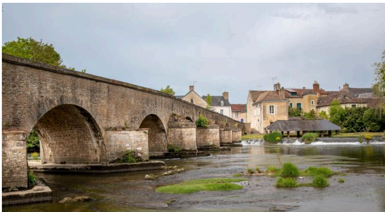
Le pont, face nord.
