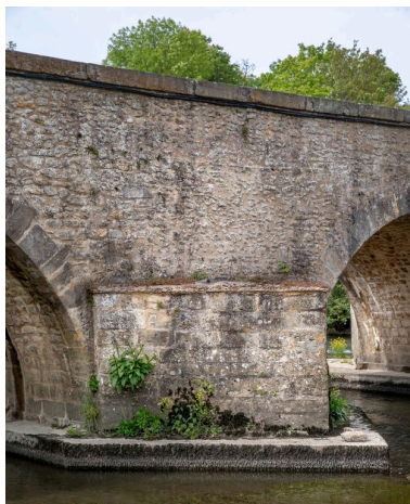
Le pont, face nord, détail d'un éperon. Phot. Pierre-Bernard Fourny IVR52_20197200951NUCA
