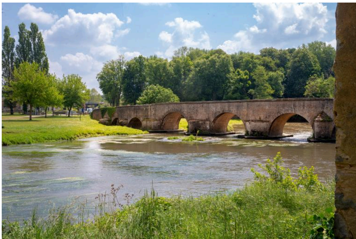
Le pont, face nord.
