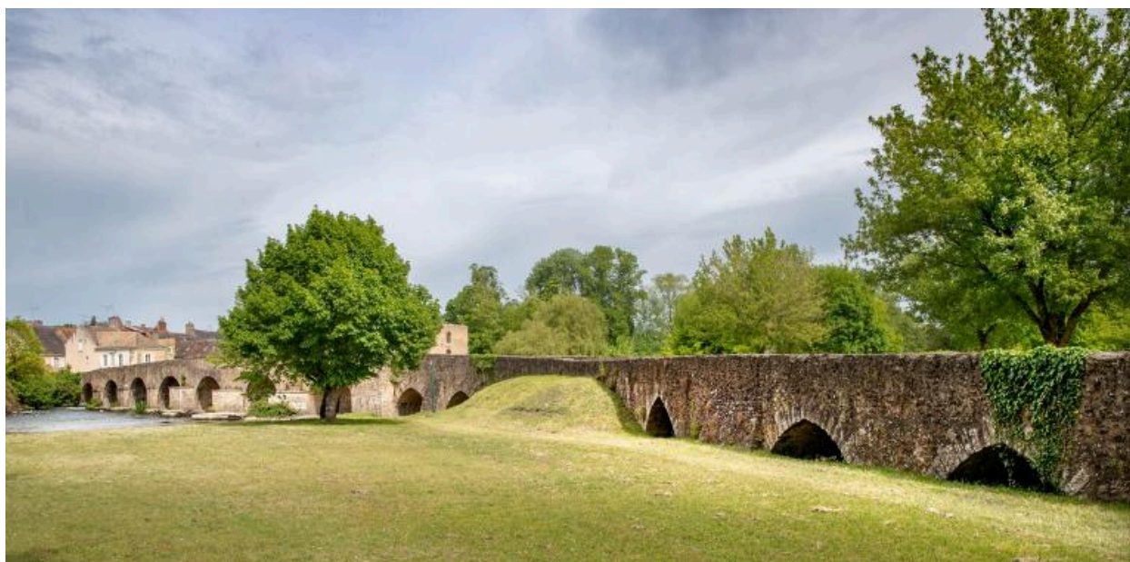
Le pont, face sud.
