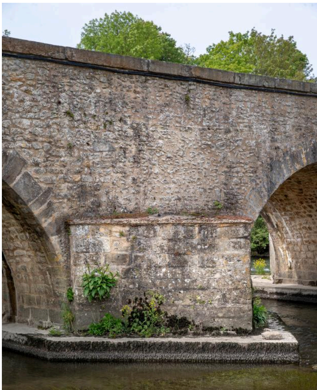
Le pont, face nord, détail d'un éperon.
