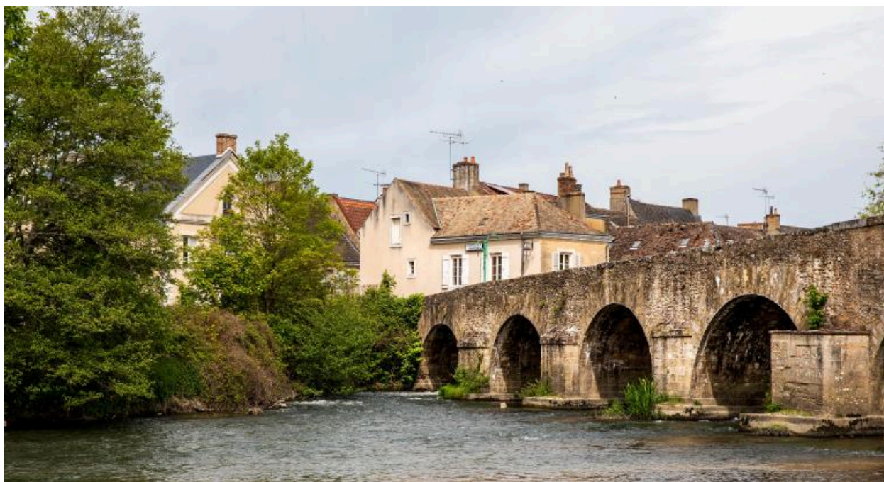
Le pont, face sud, les arches du XVII e siècle.
