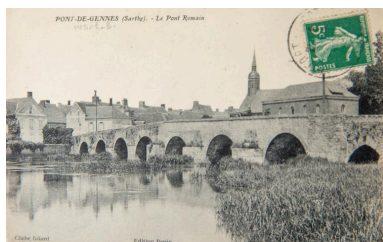
Le pont, face sud, carte postale du début du XXe siècle. Repro. Pierre-Bernard Fourny IVR52_20197201012NUCA
