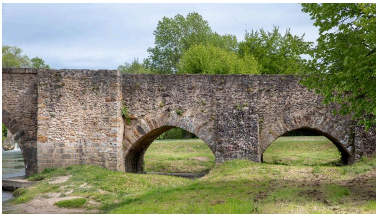
Le pont, face sud, détail de deux arches médiévales.
