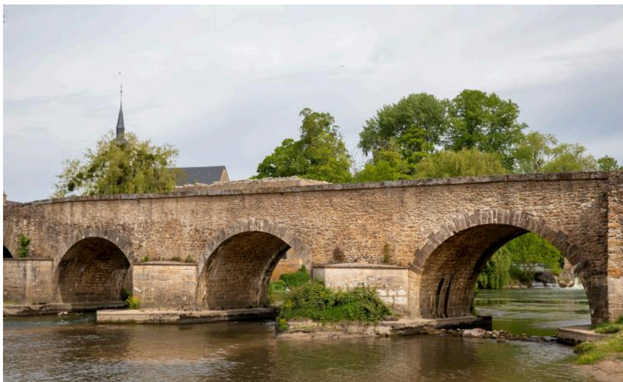
Le pont, face sud, les arches de 1834.
