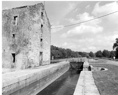
L'écluse, l'emplacement du pont- tournant et le moulin (pignon est, façade sud) vus de l'aval. Phot. François Lasa IVR52_20015300452X
