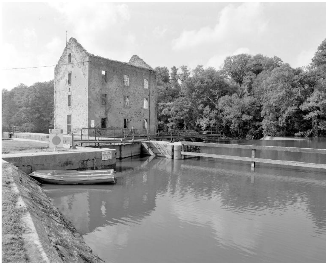
Vue de la façade nord et du pignon est du moulin.
