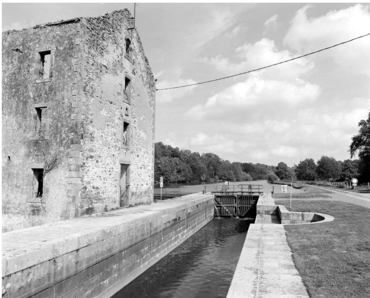
L'écluse, l'emplacement du pont-tournant et le moulin (pignon est, façade sud) vus de l'aval.
