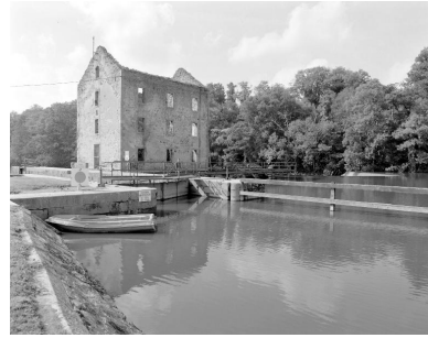
Vue de la façade nord et du pignon est du moulin. Phot. François Lasa IVR52_20015300454X
