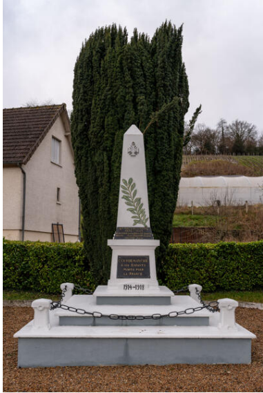
Vue d'ensemble. Phot. Jeanne Minier IVR52_20267200115NUCA
