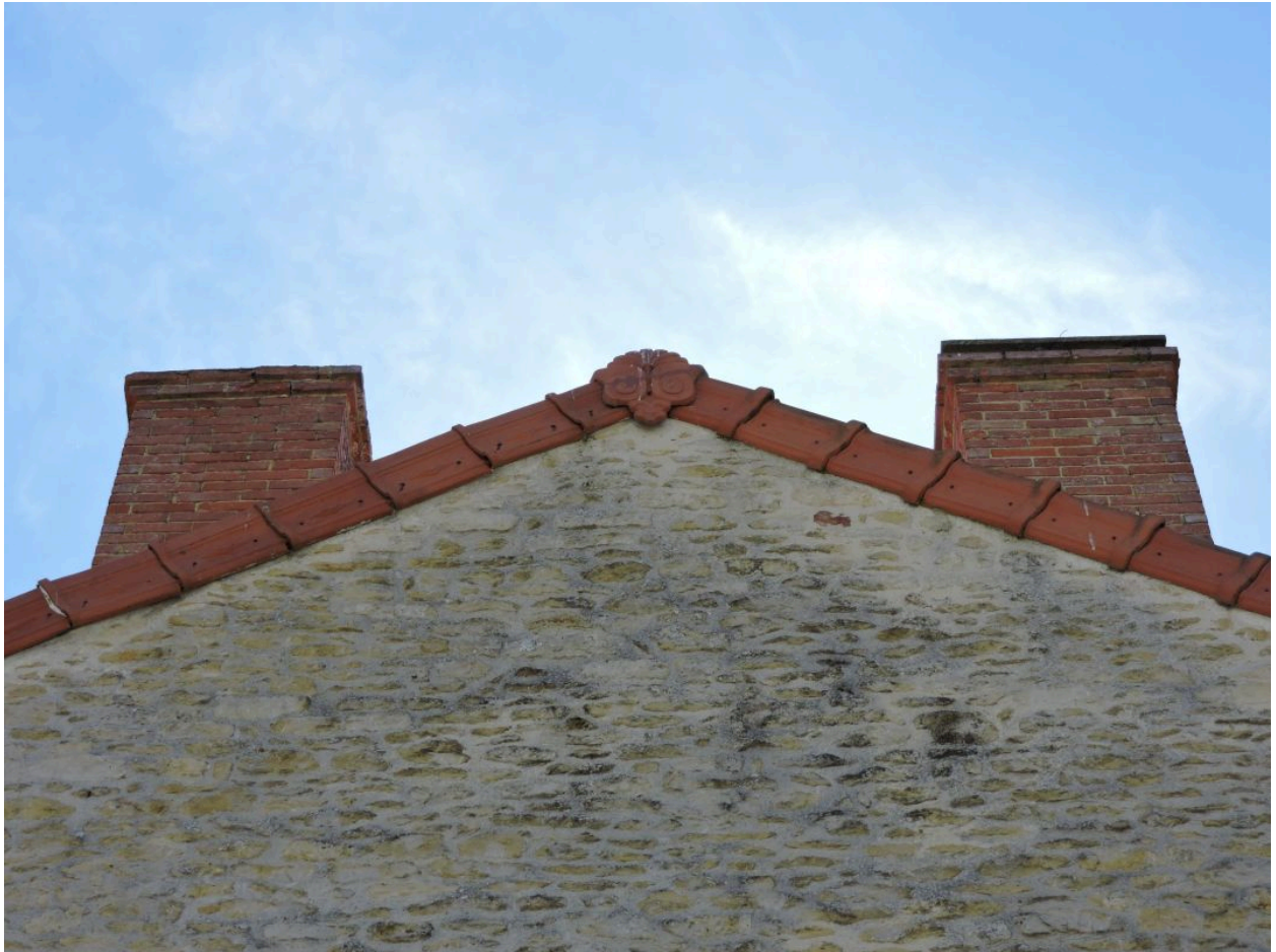
Bordure de rive sur le mur pignon nord.
