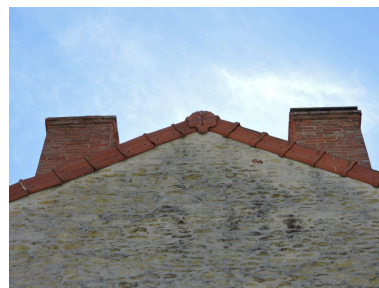
Bordure de rive sur le mur pignon nord. Phot. Yannis Suire IVR52_20198501487NUCA
