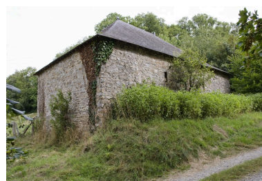
Le bûcher : vue de trois-quarts Phot. Yves Guillotin IVR52_20095300323NUCA
