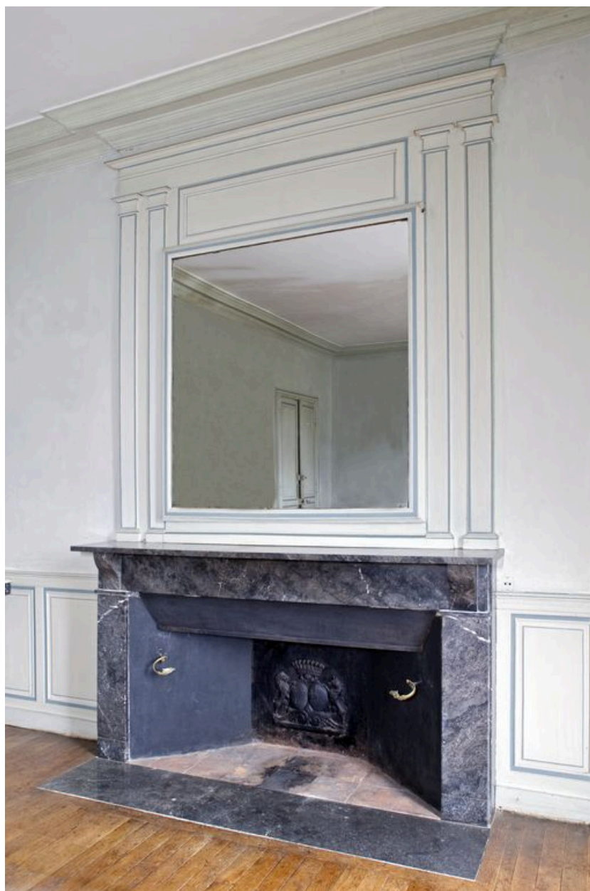
Rez-de-chaussée, salle ouest : cheminée.
