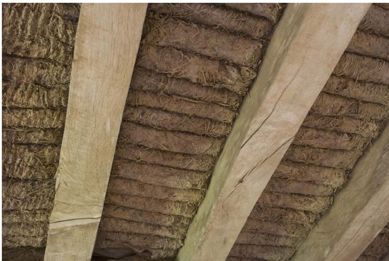
Ecurie-grange. Vue de détail du plafond du premier étage : fuseaux de torchis.
