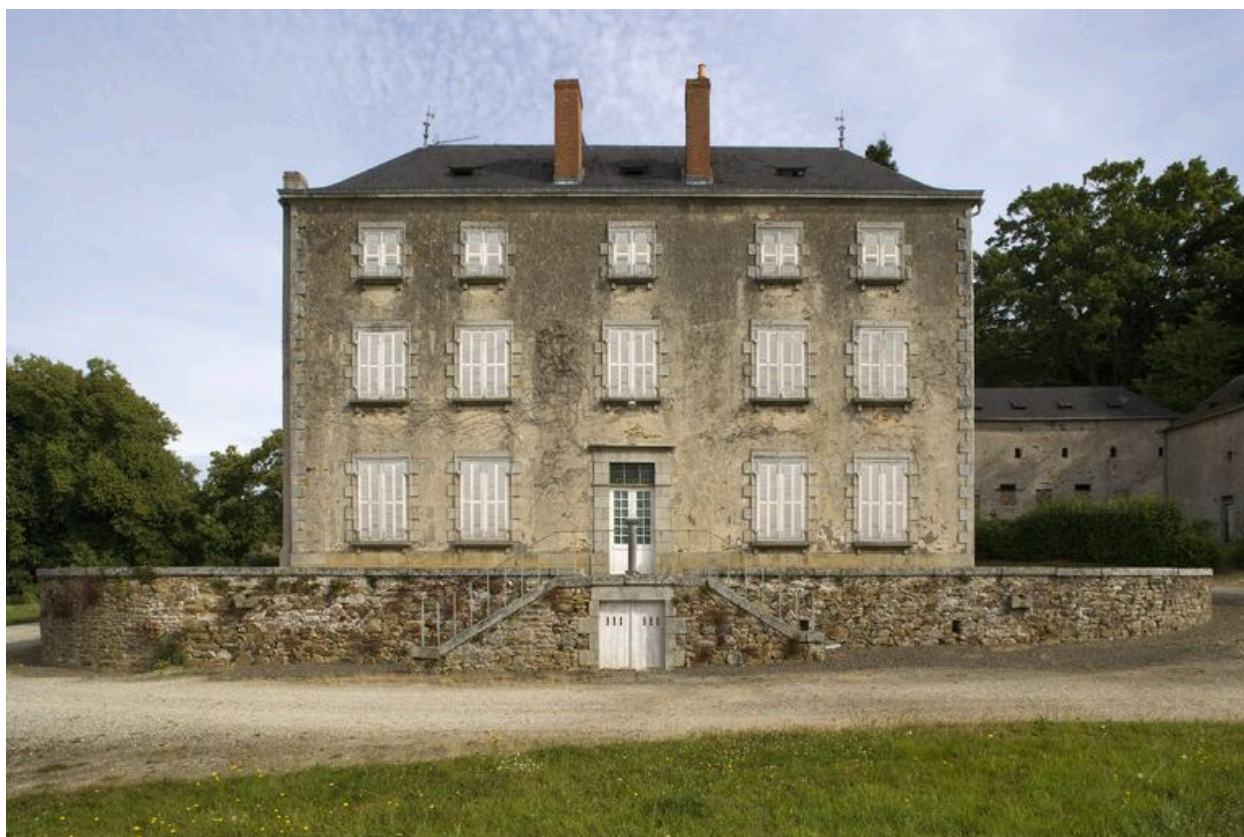
Le château : terrasse en terre-plein et façade principale vues depuis le sud.
