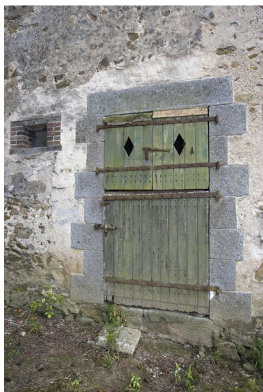
Ecurie-grange : porte à un vantaill bas et deux volets hauts. Phot. Yves Guillotin IVR52_20095300333NUCA
