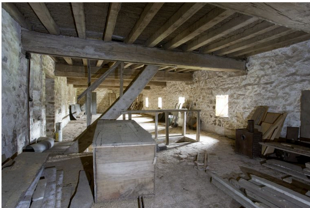
Ecurie-grange : vue d'ensemble du premier étage.
