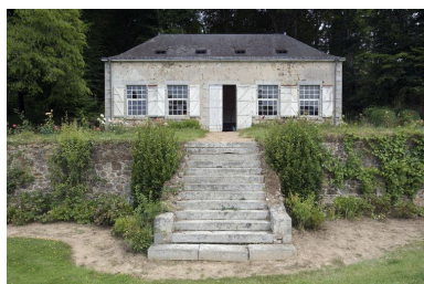
L'orangerie : vue d'ensemble depuis le sud. Phot. Yves Guillotin IVR52_20095300343NUCA
