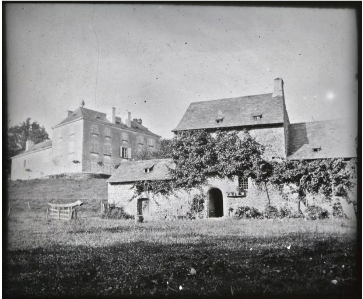
La Façade principale du logis de métayer (?) vue depuis le sud-ouest. Au second plan, les façades ouest et sud du château.
