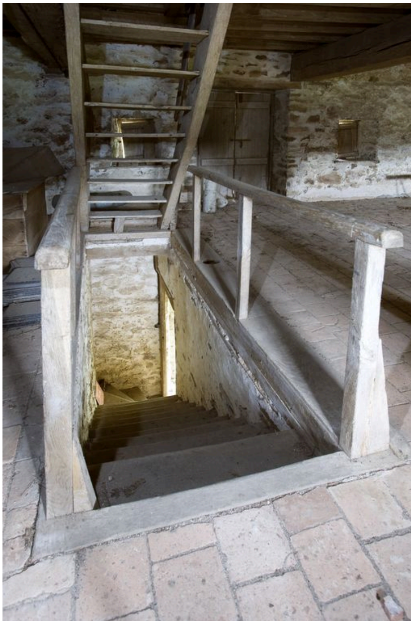
Ecurie-grange : escalier d'accès au premier étage.
