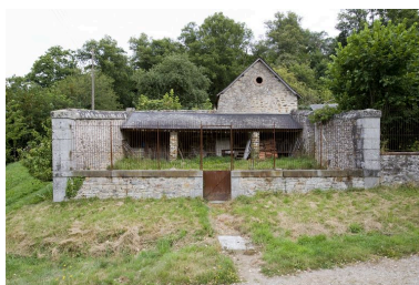
L'enclos bas (chenil ?) : vue d'ensemble depuis le sud. Phot. Yves Guillotin IVR52_20095300327NUCA
