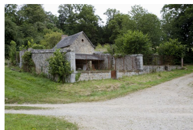
La buanderie et les enclos (chenil, potager?) : vue d'ensemble depuis le sud-ouest. Phot. Yves Guillotin IVR52_20095300328NUCA
