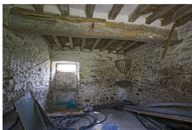
Ecurie-grange : vue d'une écurie. Phot. Yves Guillotin IVR52_20095300332NUCA
