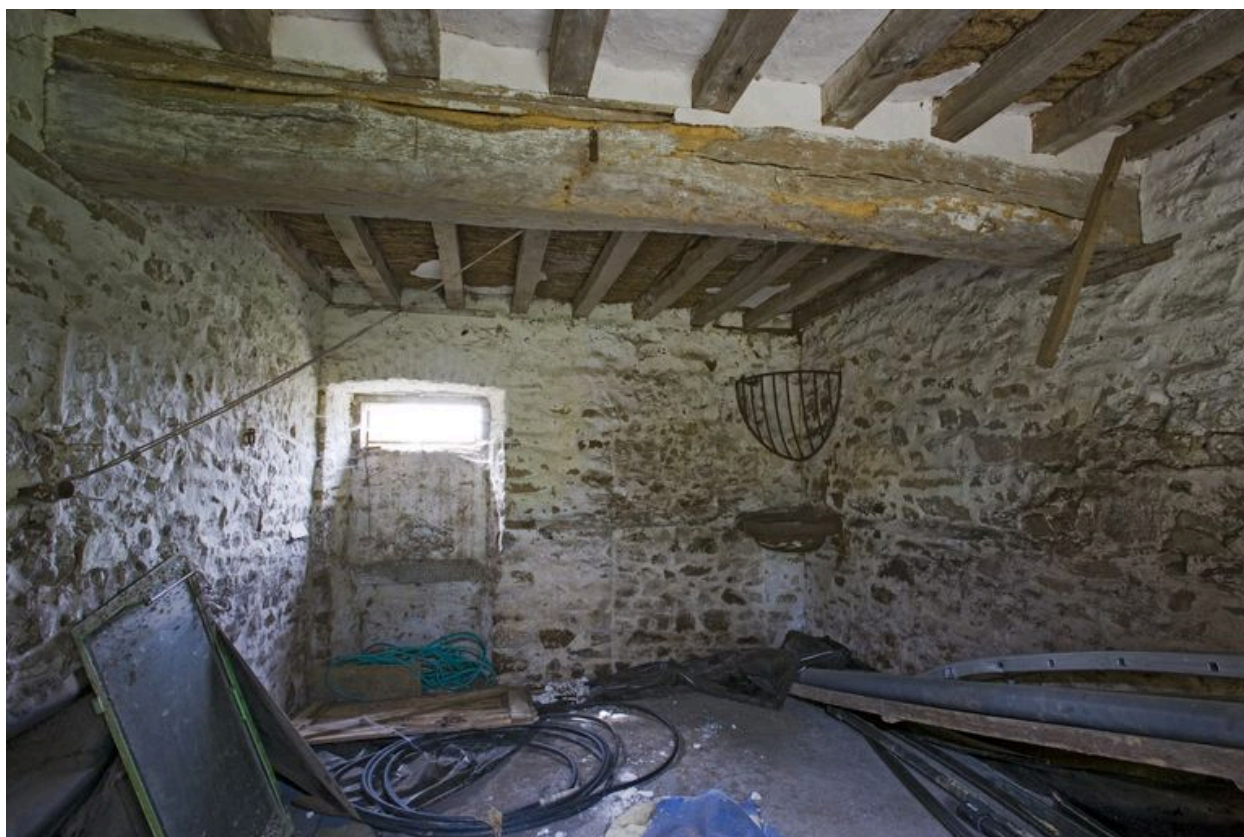
Ecurie-grange : vue d'une écurie.
