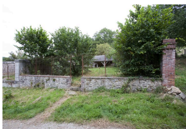
L'enclos haut (potager?) : vue d'ensemble depuis le sud. Phot. Yves Guillotin IVR52_20095300329NUCA
