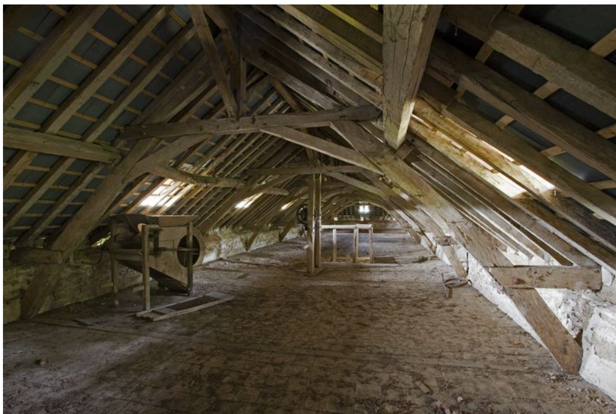
Ecurie-grange : vue d'ensemble du comble.
