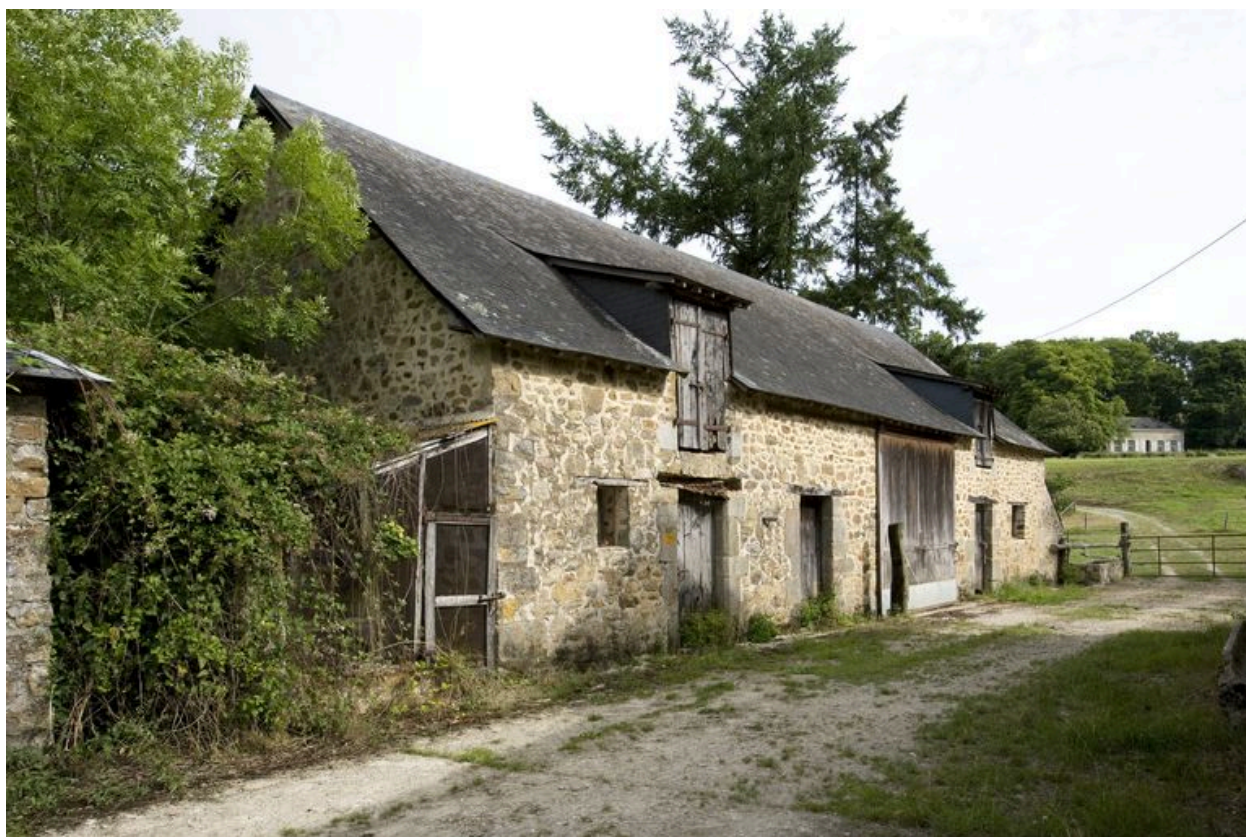
Etable-grange édiflée sur l'ancienne motte : vue depuis le sud-ouest.
