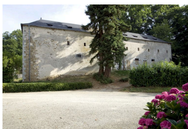
Ecurie-grange : façade postérieure vue depuis le sud. Phot. Yves Guillotin IVR52_20095300304NUCA
