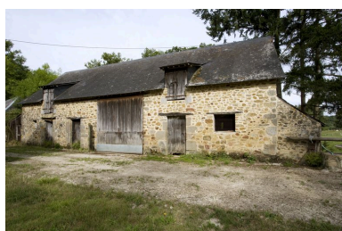
Etable-grange édifée sur l'ancienne motte : vue depuis le sud-est. Phot. Yves Guillotin IVR52_20095300315NUCA
