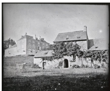
La façade principale du logis de métayer (?) vue depuis le sud-ouest. Au second plan, les façades ouest et sud du château. Repro. Yves Guillotin IVR52_20095300433NUCA
