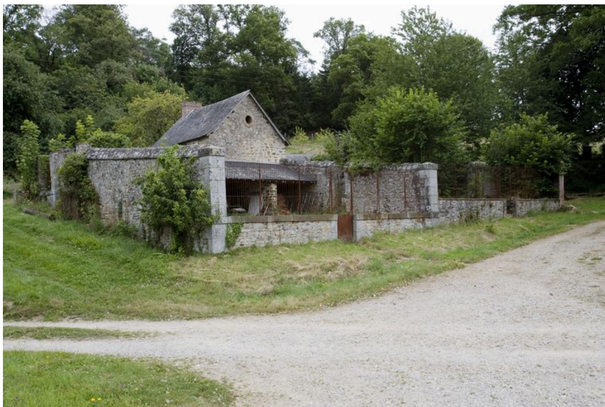
La buanderie et les enclos (chenil, potager?) : vue d'ensemble depuis le sud-ouest.
