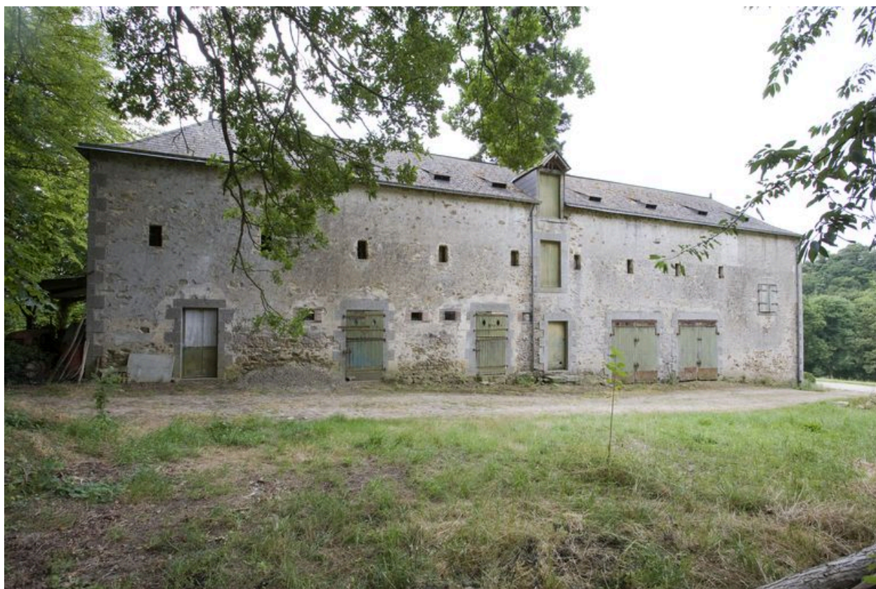
Ecurie-grange : façade antérieure vue depuis le nord.
