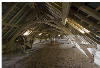
Ecurie-grange : vue d'ensemble du comble. Phot. Yves Guillotin IVR52_20095300338NUCA
