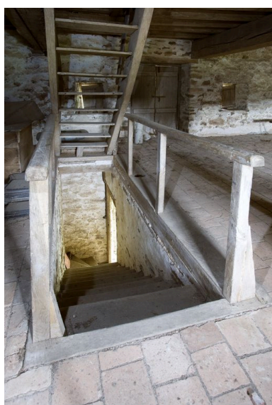
Ecurie-grange : escalier d'accès au premier étage. Phot. Yves Guillotin IVR52_20095300334NUCA
