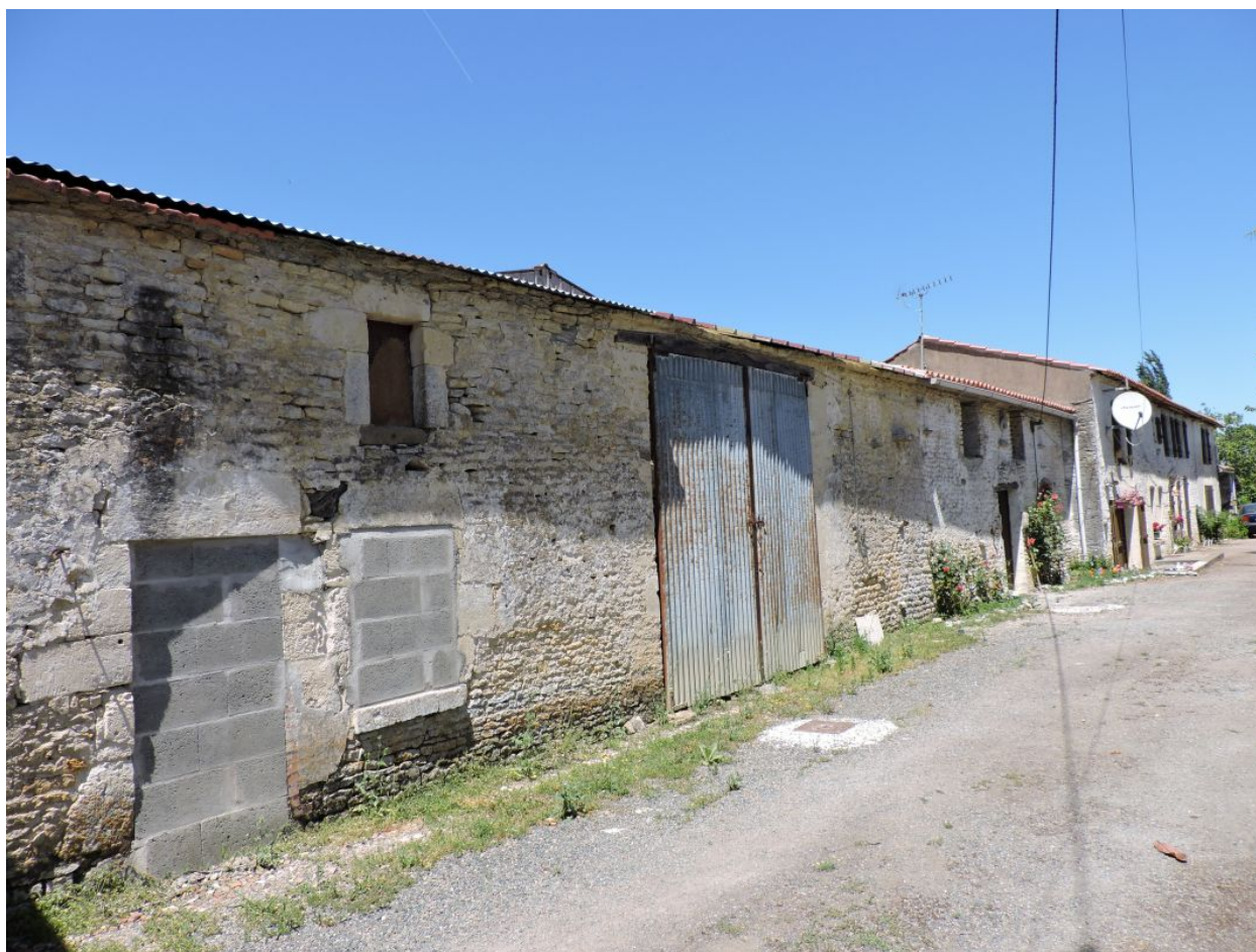
Le logis, à gauche, et les dépendances dans son prolongement, au centre et à droite.
