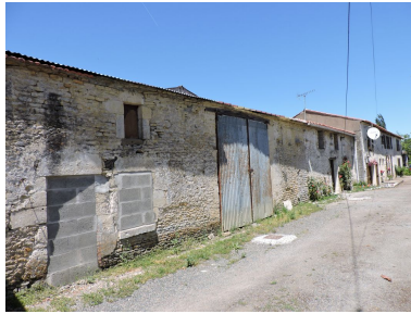
Le logis, à gauche, et les dépendances dans son prolongement, au centre et à droite. Phot. Yannis Suire IVR52_20198502656NUCA
