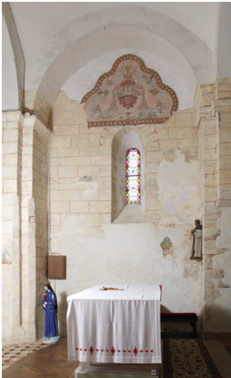
Chœur, première travée, mur nord. Vue d'ensemble.
