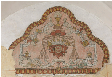
Chœur, première travée, mur nord. Trophée liturgique armorié.
