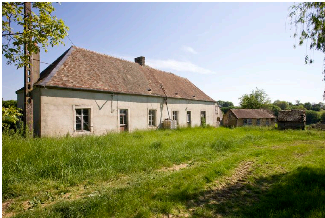
Chavigné, logis court construit avant 1835, augmenté à gauche en logis long et remanié vers 1864.
