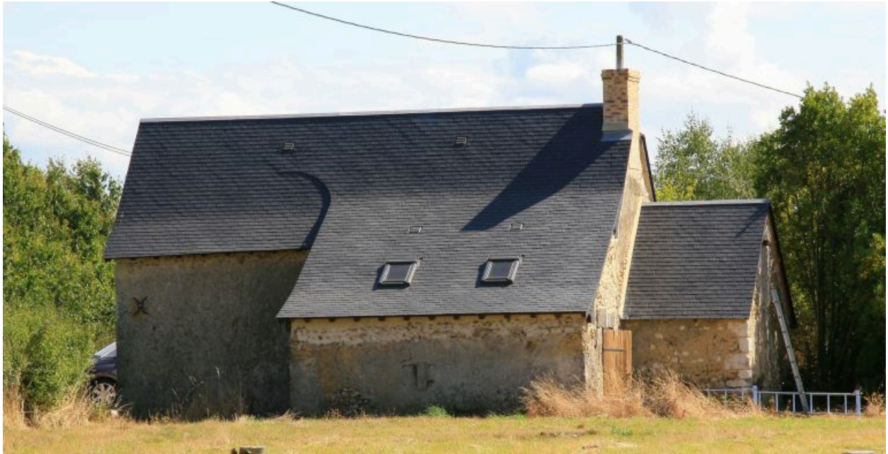
La maison : façade postérieure.
