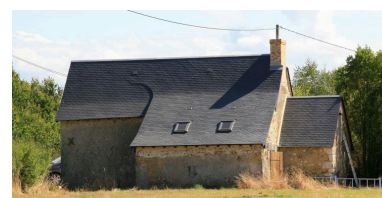
La maison : façade postérieure. Phot. Jean-Baptiste Darrasse IVR52_20087201900NUCA
