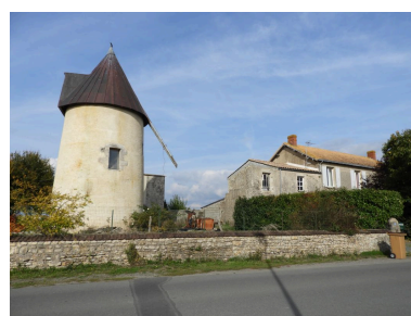
Le moulin de Galerne et l'ancienne ferme qui le jouxte. Phot. Yannis Suire IVR52_20178500226NUCA
