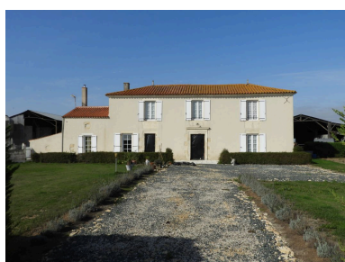
Le logis de ferme de Sainte-Augustine. Phot. Yannis Suire IVR52_20188500086NUCA
