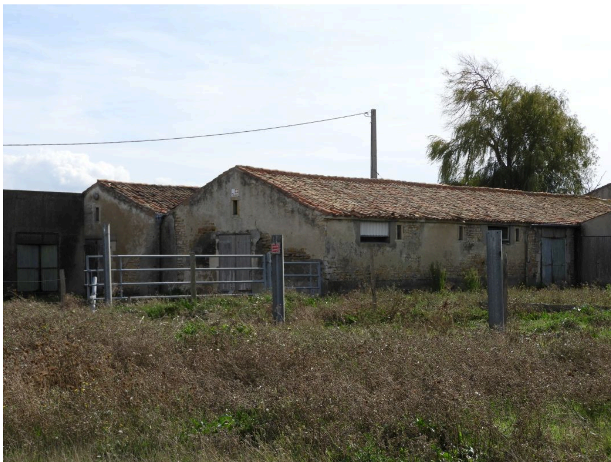
Les deux granges-étables parallèles, à façade en pignon, de la ferme de la Prise.
