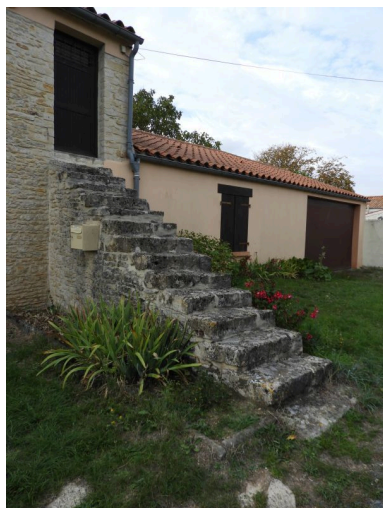
Escalier extérieur, 2 rue des Ecoles. Phot. Yannis Suire IVR52_20188500099NUCA
