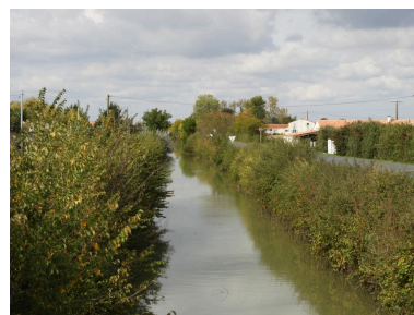
Le canal de Vienne au pont de Puyravault, traversant l'ancienne île, vu en direction du nord. Phot. Yannis Suire IVR52_20178500215NUCA
