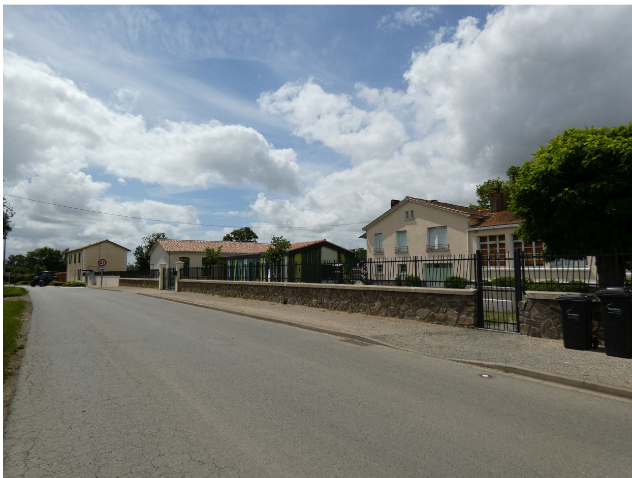
L'école vue depuis le sud-est.
