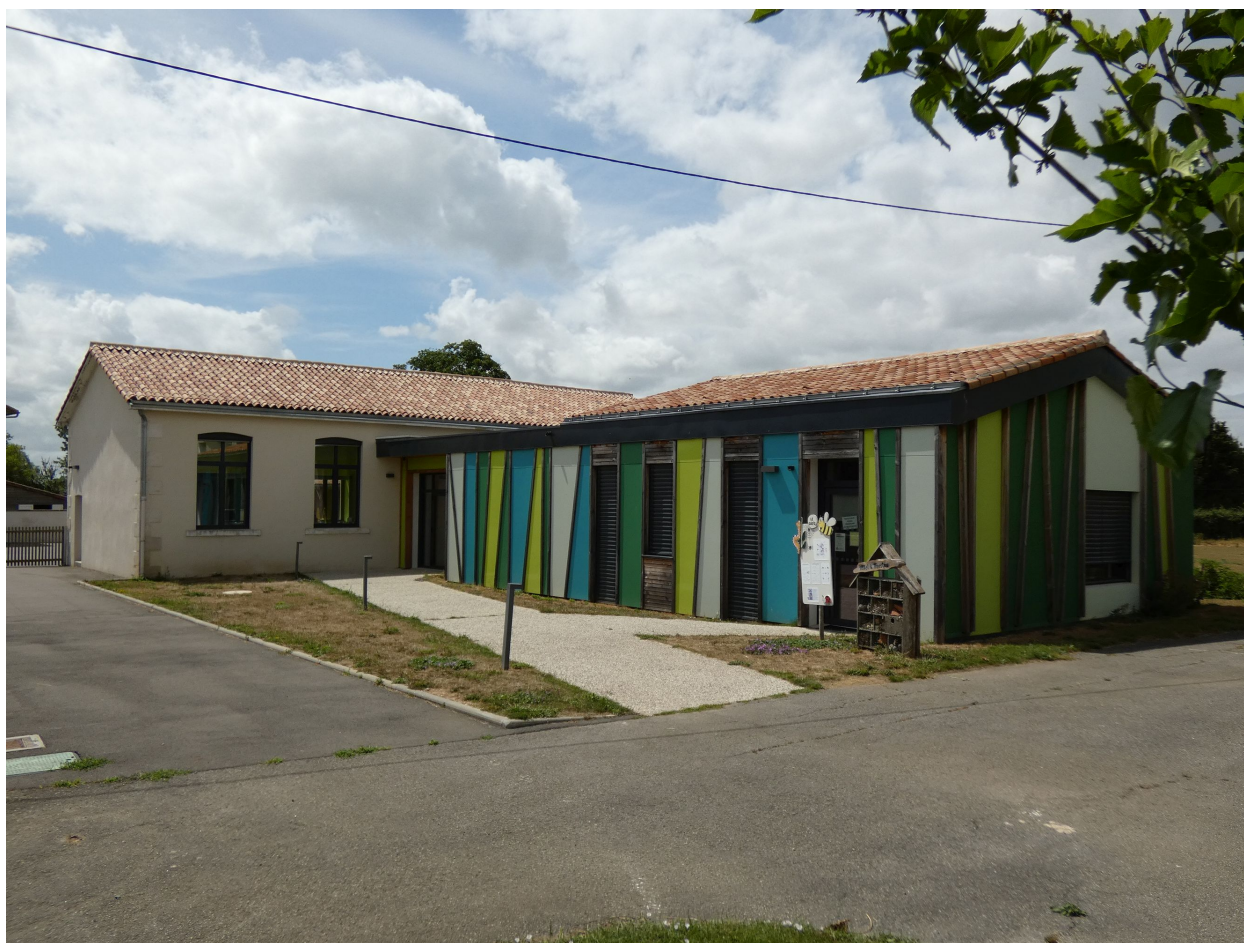
Le bâtiment de classe des années 2010, en retour d'équerre à l'arrière de celui de la fin du 19e siècle, vu depuis le sud-est.
