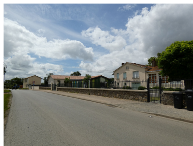
L'école vue depuis le sud-est.
