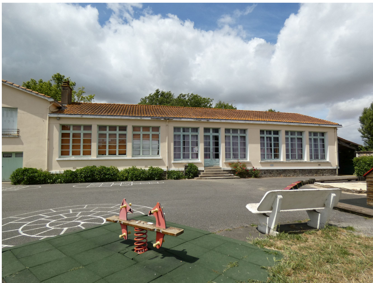
Le bâtiment de classes des années 1960 vu depuis le sud.
