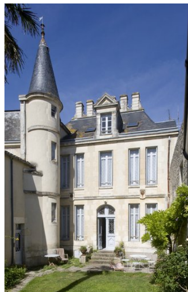
Façade sur jardin. Phot. Patrice Giraud IVR52_20108500343NUCA
