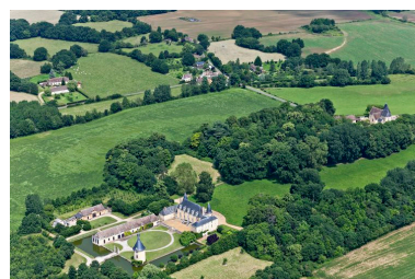
Le paysage bocager autour du château, du village et de la ferme des Bommeries. Phot. Yves Guillotin IVR52_20137201270NUCA
