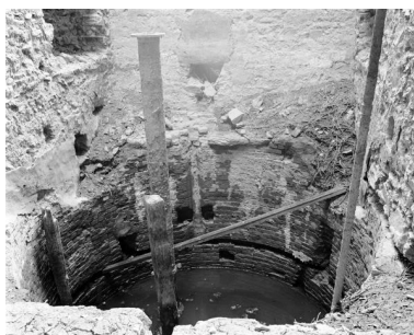
Puits situé à la verticale de la cage, vue depuis le sud, partie inférieure de l'élévation, four de Sainte Barbe, Montjean-sur-Loire. Phot. Bruno Rousseau IVR52_19854901733X
