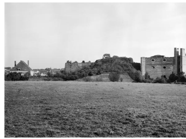
Vue d'ensemble du site de Pincourt depuis le sud, de gauche à droite, maison du contremaître et bureaux, le four Sainte Barbe, le massif de liaison, le bâtiment est et l'élévateur ; Montjean-sur-Loire. Phot. Bruno Rousseau IVR52_19854901756V
