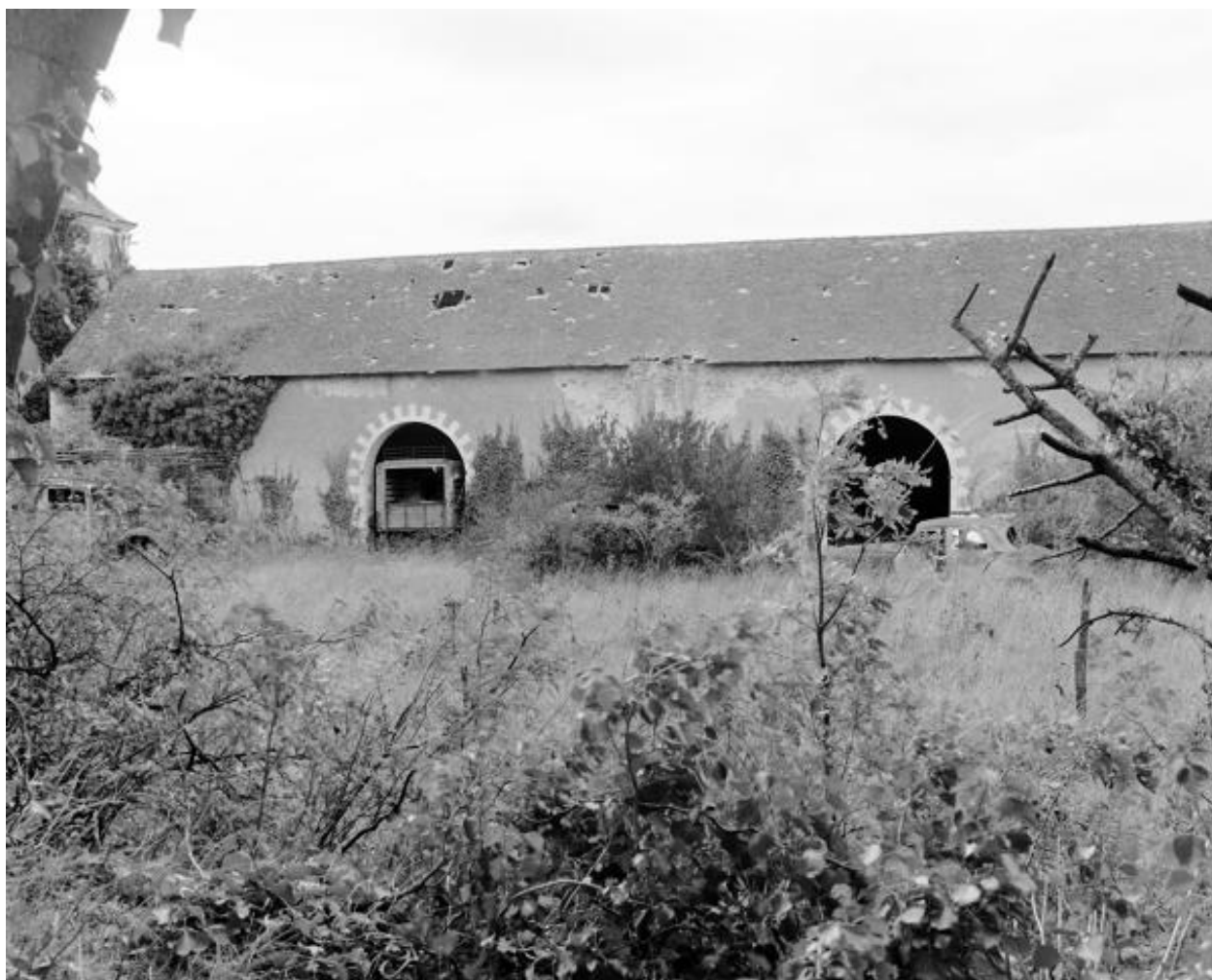
Etables à chevaux et remises ouest, face est, four de Sainte Barbe, Montjean-sur-Loire.
