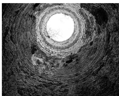
Chambre de combustion du four de Sainte Barbe, vue verticale de bas en haut, Montjean-sur-Loire. Phot. Bruno Rousseau IVR52_19854901728X
