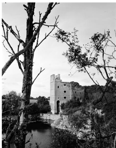
Vue d'ensemble depuis l'est sur la carrière, le bâtiment est et l'élévateur, four de Sainte Barbe, Montjean-sur-Loire. Phot. Bruno Rousseau IVR52_19854901760V
