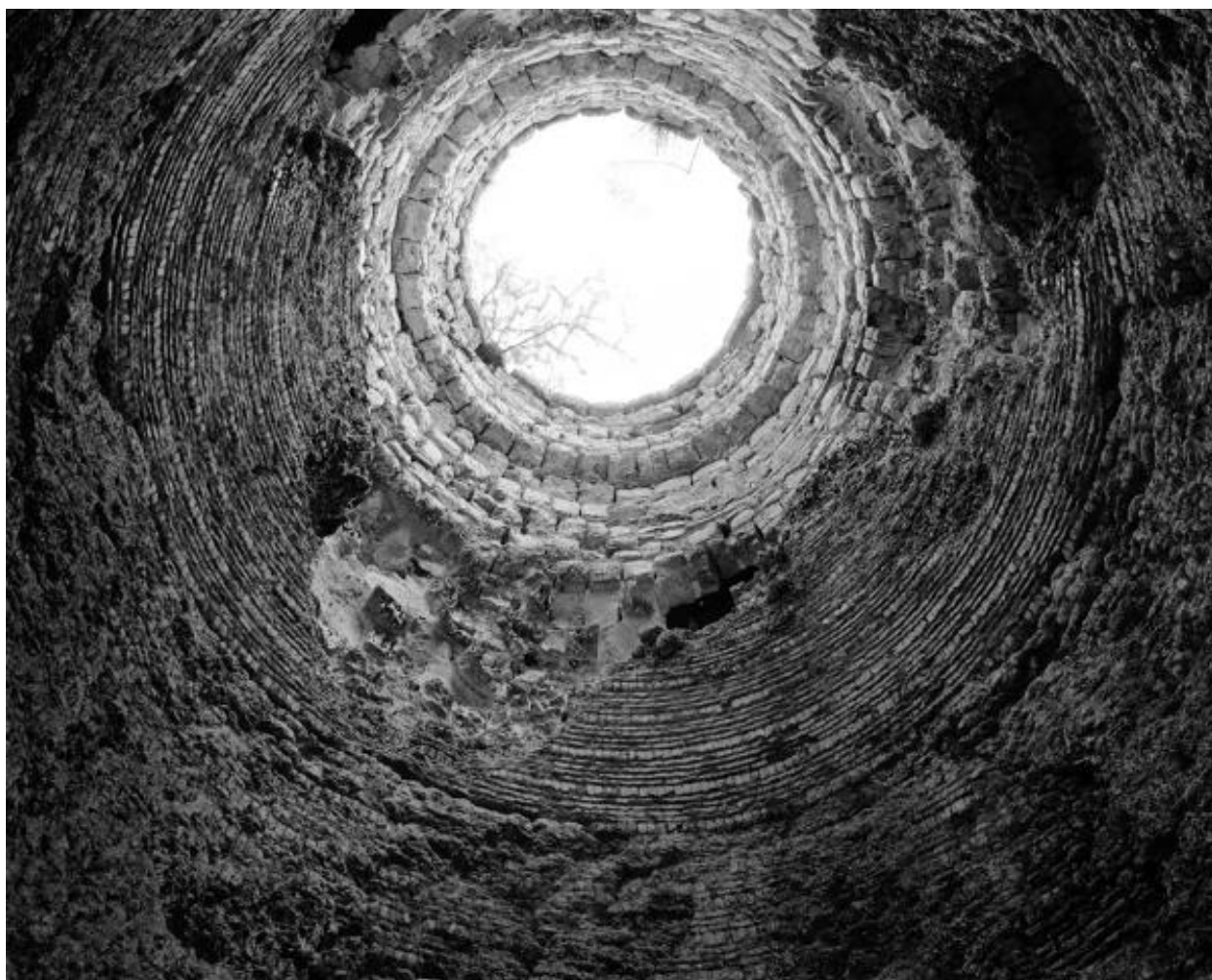
Chambre de combustion du four de Sainte Barbe, vue verticale de bas en haut, Montjean-sur-Loire.
