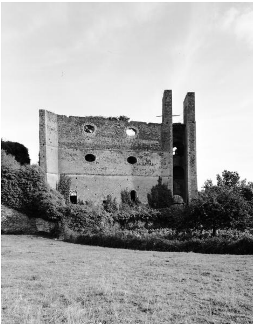
Bâtiment est et élévateur, face sud-ouest, site de Pincourt, four à chaux de Sainte Barbe, Montjean-sur-Loire.
