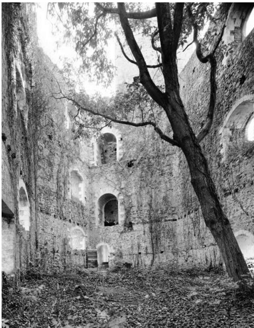
Intérieur de la grande salle du bâtiment est, vue du nord-ouest vers le sud-est, four de Sainte Barbe, Montjean-sur-Loire.
