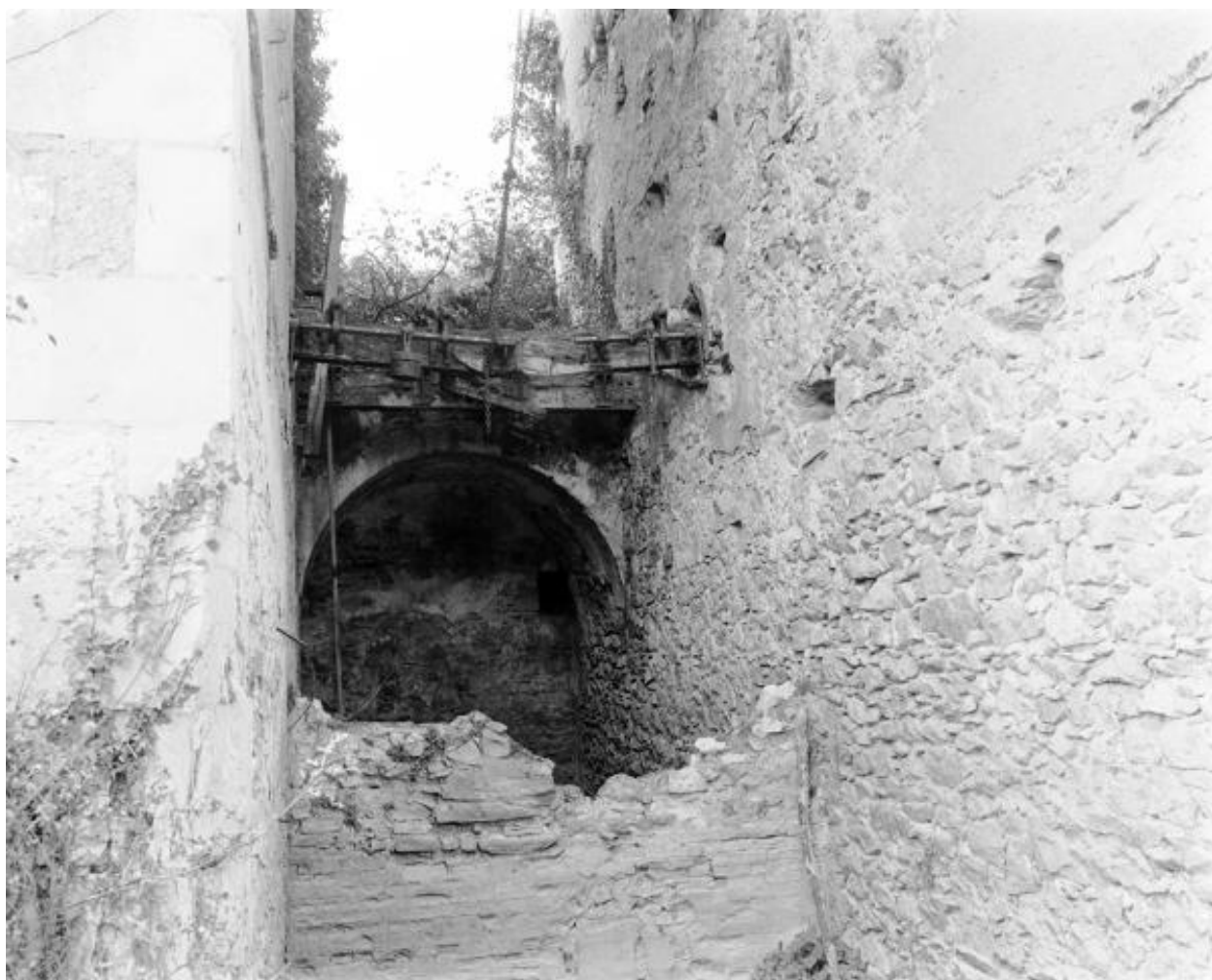
Partie inférieure de l'élévateur, vue depuis le nord-est, four de Sainte Barbe, Montjean-sur-Loire.
