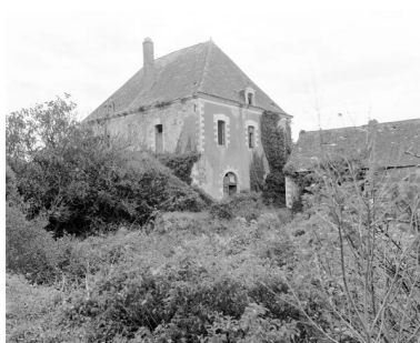
Faces est et nord de la maison du contremaître et des bureaux, four de Sainte Barbe, Montjean-sur-Loire. Phot. Bruno Rousseau IVR52_19854901726X
