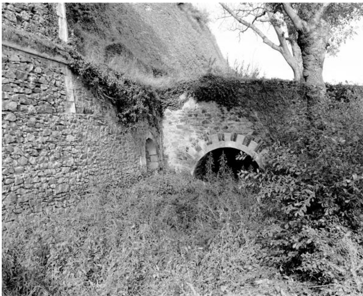
Vue depuis l'est de la face nord-est de l'élévateur et du bassin n°3, à gauche, débouché de l'aqueduc du ruisseau de Pincourt, à droite, départ du canal vers le nord-ouest, four de Sainte Barbe, Montjean-sur-Loire.
