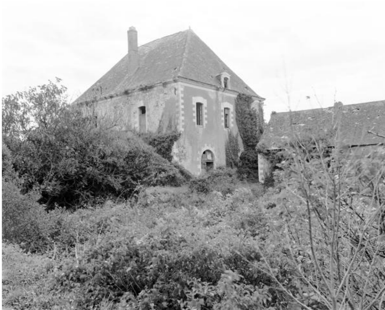
Faces est et nord de la maison du contremaître et des bureaux, four de Sainte Barbe, Montjean-sur-Loire.
