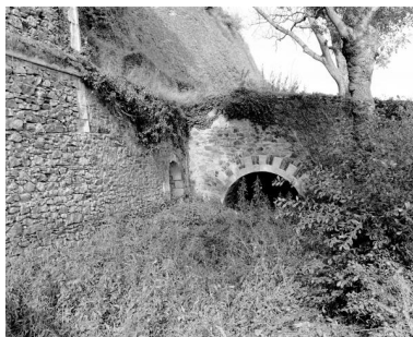
Vue depuis l'est de la face nord-est de l'élévateur et du bassin n°3, à gauche, débouché de l'aqueduc du ruisseau de Pincourt, à droite, départ du canal vers le nord-ouest, four de Sainte Barbe, Montjean-sur-Loire. Phot. Bruno Rousseau IVR52_19854901730X
