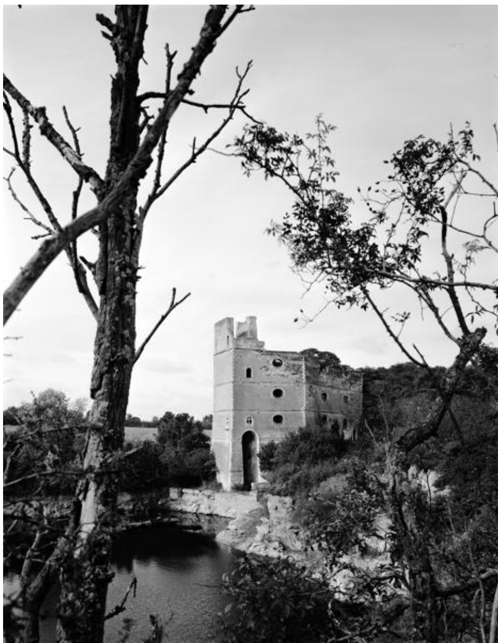
Vue d'ensemble depuis l'est sur la carrière, le bâtiment est et l'élévateur, four de Sainte Barbe, Montjean-sur-Loire.
