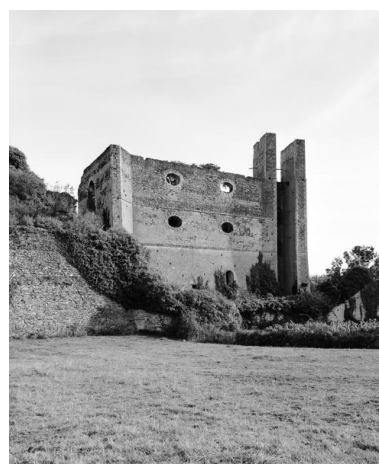
Bâtiment est et élévateur, faces nord-ouest et sud-ouest, site
