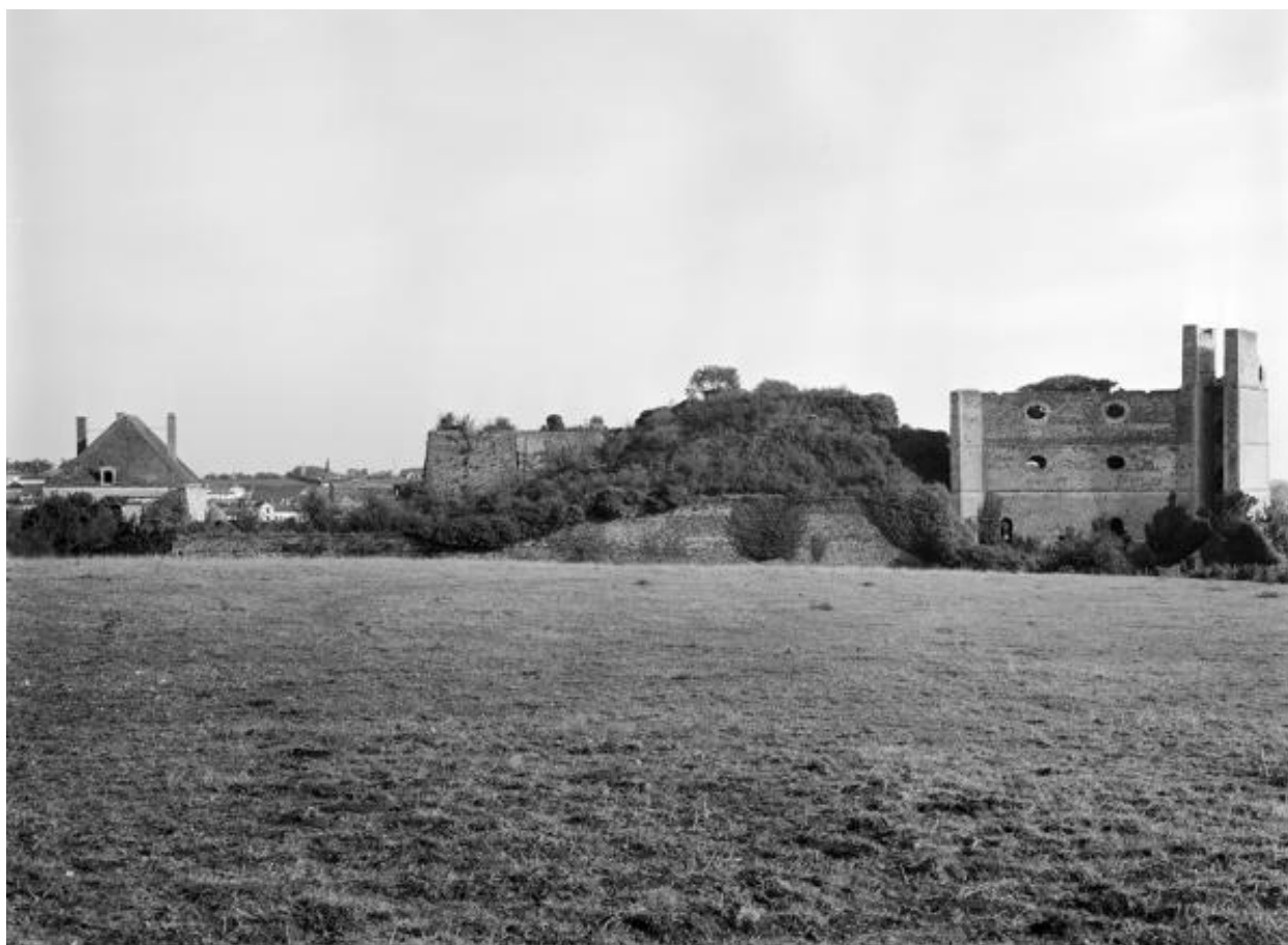
Vue d'ensemble du site de Pincourt depuis le sud, de gauche à droite, maison du contremaître et bureaux, le four Sainte Barbe, le massif de liaison, le bâtiment est et l'élévateur ; Montjean-sur-Loire.
