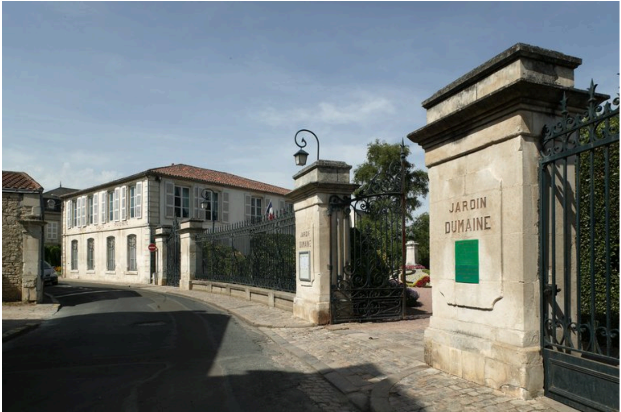
Entrée principale du jardin, rue de l'Hôtel-de-ville. Au fond, l'hôtel de ville.
