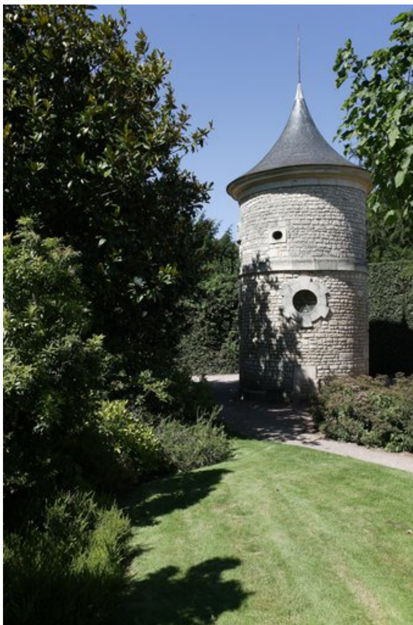
Ancien pigeonnier de la maison Dumaine, au sud du jardin.
