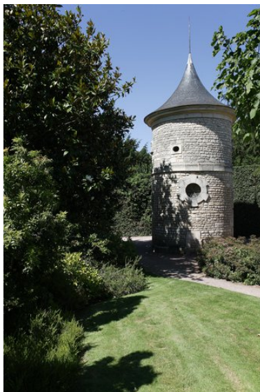
Ancien pigeonnier de la maison Dumaine, au sud du jardin. Phot. Patrice Giraud IVR52_20088501063NUCA
