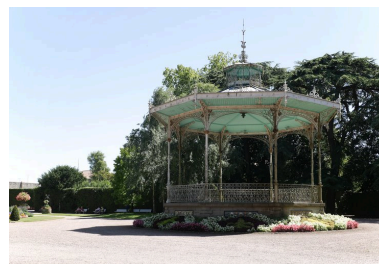
Vue du kiosque, prise du nord-est. Phot. Patrice Giraud IVR52_20088501053NUCA
