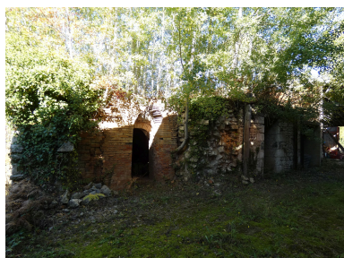
Les fours vus depuis le sud-ouest. Phot. Yannis Suire IVR52_20228500800NUCA
