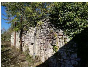
L'élévation ouest des four, en moellons calcaires ceinturés de métal. Phot. Yannis Suire IVR52_20228500813NUCA
