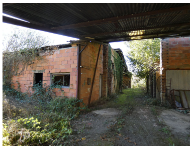
Le séchoir, à gauche, et les fours, à droite, vus depuis l'est. Phot. Yannis Suire IVR52_20228500795NUCA
