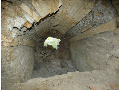
Un des deux foyers du second four, vu depuis le sud. Phot. Yannis Suire IVR52_20228500810NUCA
