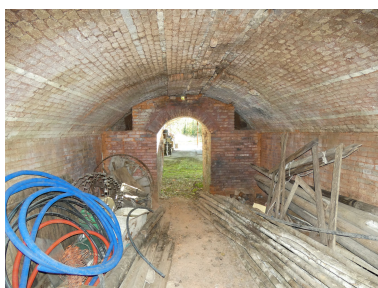
La chambre de cuisson du premier four, vue depuis le nord. Phot. Yannis Suire IVR52_20228500804NUCA
