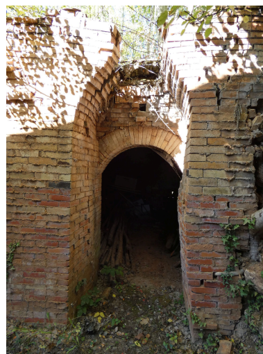
La porte d'enfournement du premier four, à l'ouest, vue depuis le sud. Phot. Yannis Suire IVR52_20228500799NUCA
