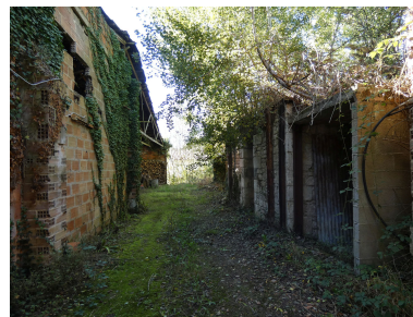
Le séchoir, à gauche, et les fours, à droite, vus depuis l'est. Phot. Yannis Suire IVR52_20228500796NUCA
