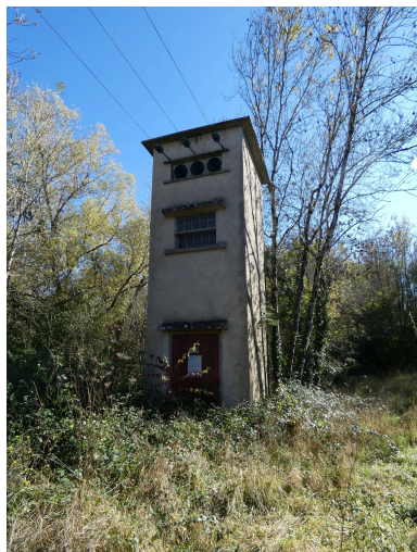
Le transformateur électrique vu depuis le nord. Phot. Yannis Suire IVR52_20228500817NUCA
