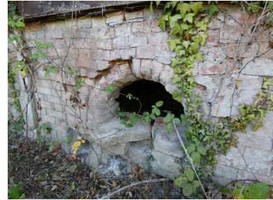
Une des gueules de foyer. Phot. Yannis Suire IVR52_20228500815NUCA
