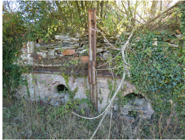
Les gueules de foyers du second four, vues depuis le nord. Phot. Yannis Suire IVR52_20228500814NUCA
