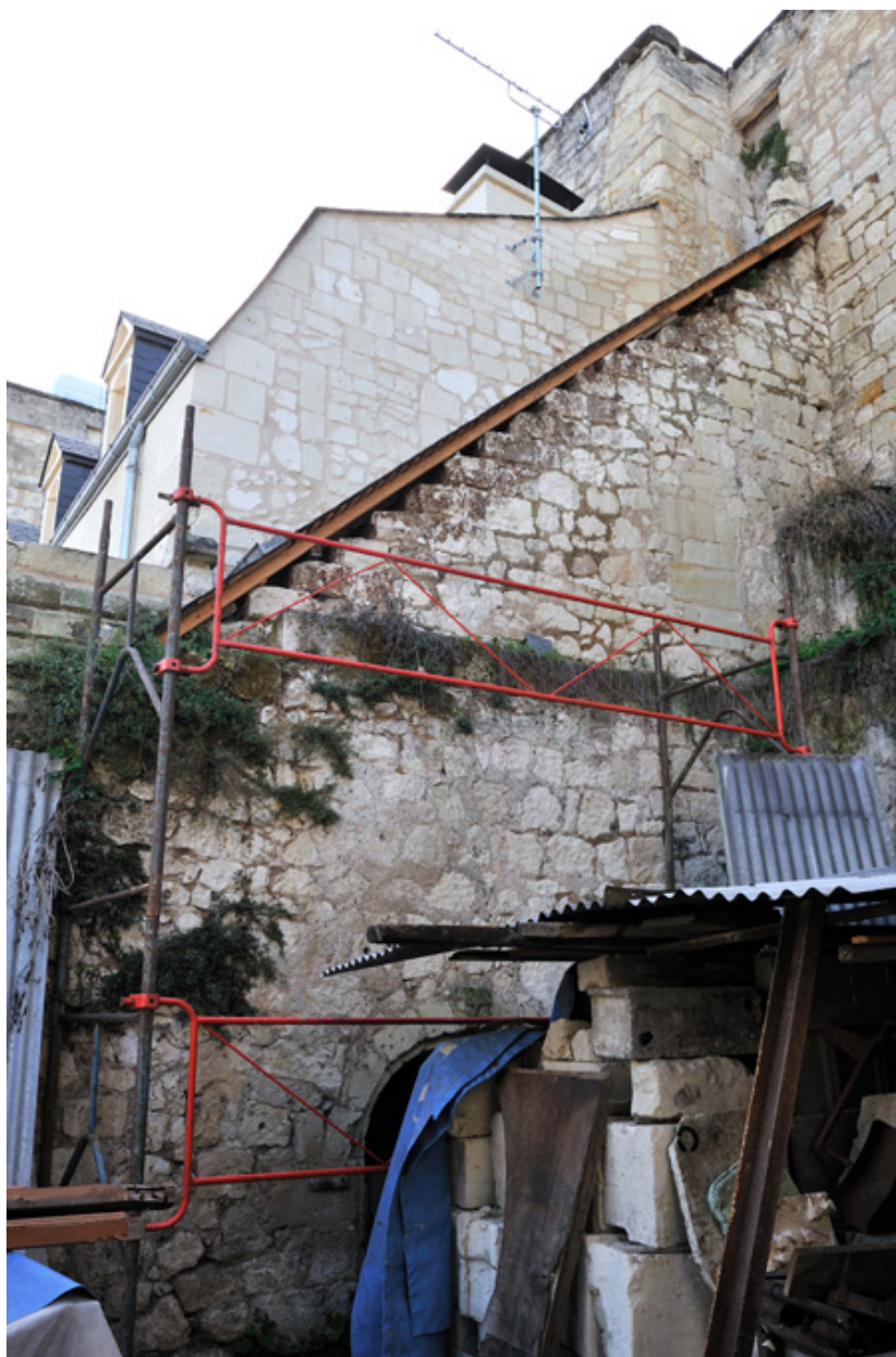
Face ouest de la maison centrale : escalier latéral qui permettait l'accès de la Basse-Rue à la Haute-Rue
