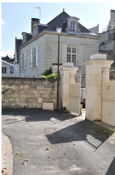
Vue générale, avec ancien portail d'accès depuis la Basse-Rue Phot. Bruno Rousseau, Phot. Youenn Communeau IVR52_20114902495NUCA
