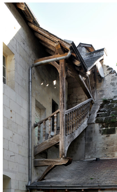
Escalier extérieur (ISMH) en façade postérieure de la maison principale Phot. Bruno Rousseau, Phot. Youenn Communeau IVR52_20114902488NUCA
