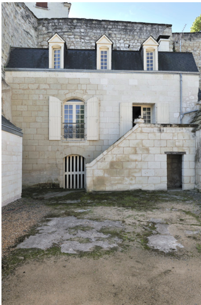
Vue générale de la maison centrale
