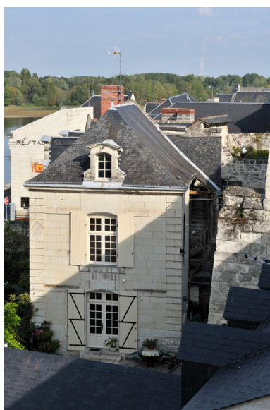
Vue d'ensemble sur le bâtiment principal, avec l'escalier extérieur côté sud. Phot. Bruno Rousseau, Phot. Youenn Communeau IVR52_20114902621NUCA
