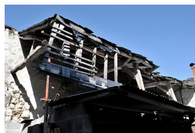
Ancien chaix (ruiné) : vestiges de la toiture en appentis mansardé Phot. Bruno Rousseau, Phot. Youenn Communeau IVR52_20114902494NUCA
