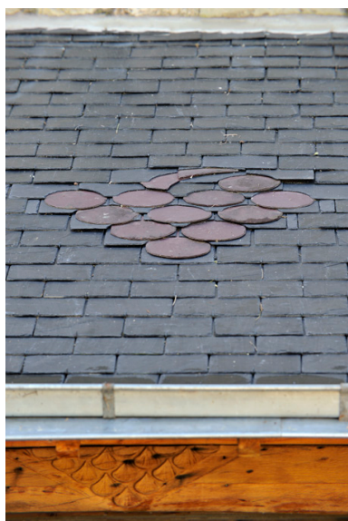
Grappe en schiste pourpre, ancien ornement de la toiture du chaix, en remploi sur un appentis Phot. Bruno Rousseau, Phot. Youenn Communeau IVR52_20114902489NUCA
