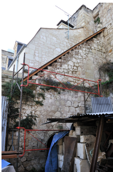
Face ouest de la maison centrale : escalier latéral qui permettait l'accès de la Basse-Rue à la Haute-Rue Phot. Bruno Rousseau, Phot. Youenn Communeau IVR52_20114902493NUCA
