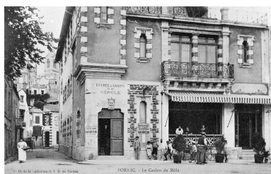
Rez-de-chaussée et premier étage du casino. Autr. G.I.D., Repro. Denis Pillet IVR52_19944400434X
