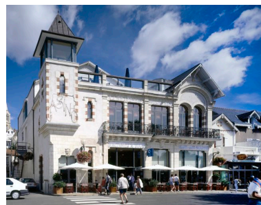
Elévation antérieure, fin 20e siècle. Phot. Denis Pillet IVR52_19964401225VA
