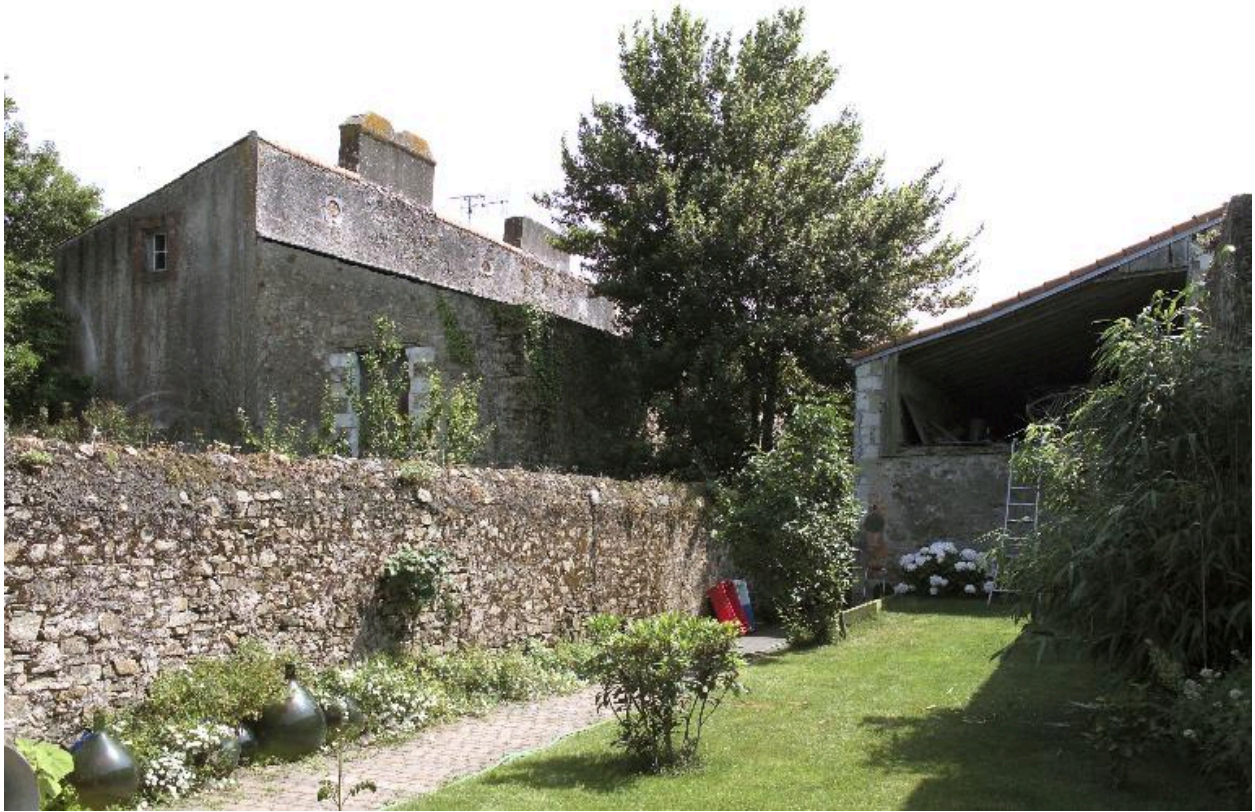
A droite, l'ancien magasin ouvrant sur la rue Pierre-Jubau vu depuis le jardin.
