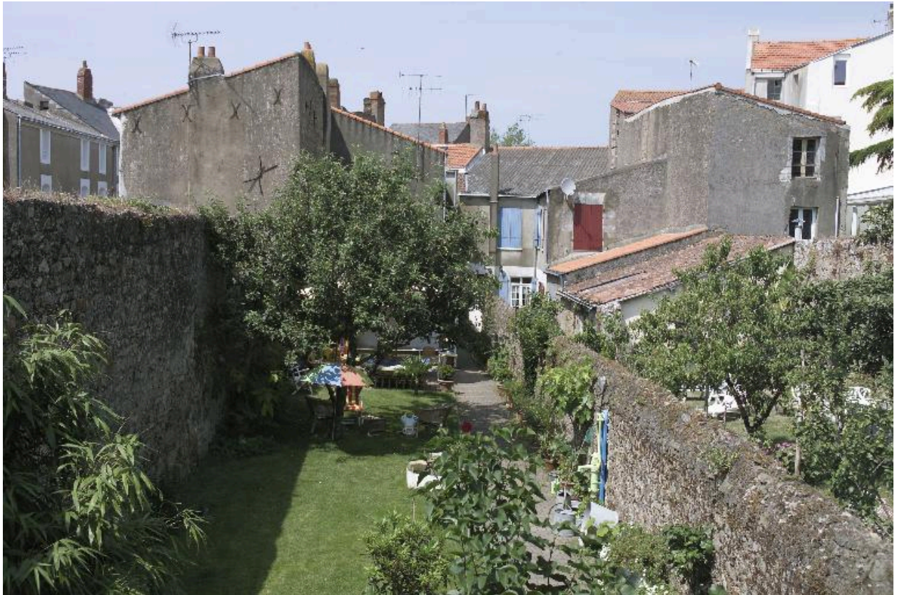
La façade postérieure de la maison n° 25 dans l'axe.
