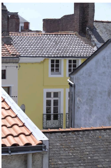
La façade sur la rue, vue prise depuis la maison n° 11 quai Sadi-Carnot. Phot. Denis Pillet IVR52_20034400591NUCA
