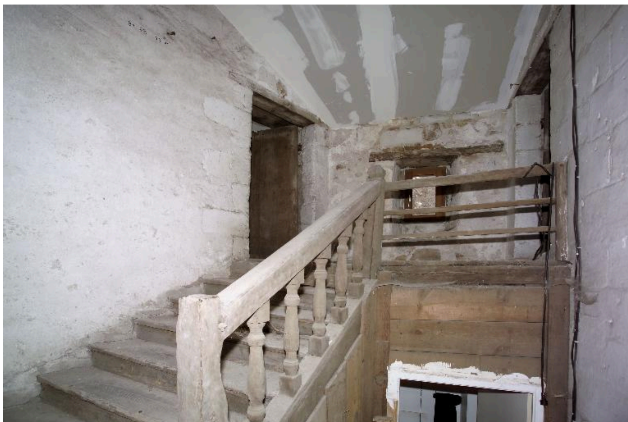
L'escalier, vue prise vers l'étage de comble.
