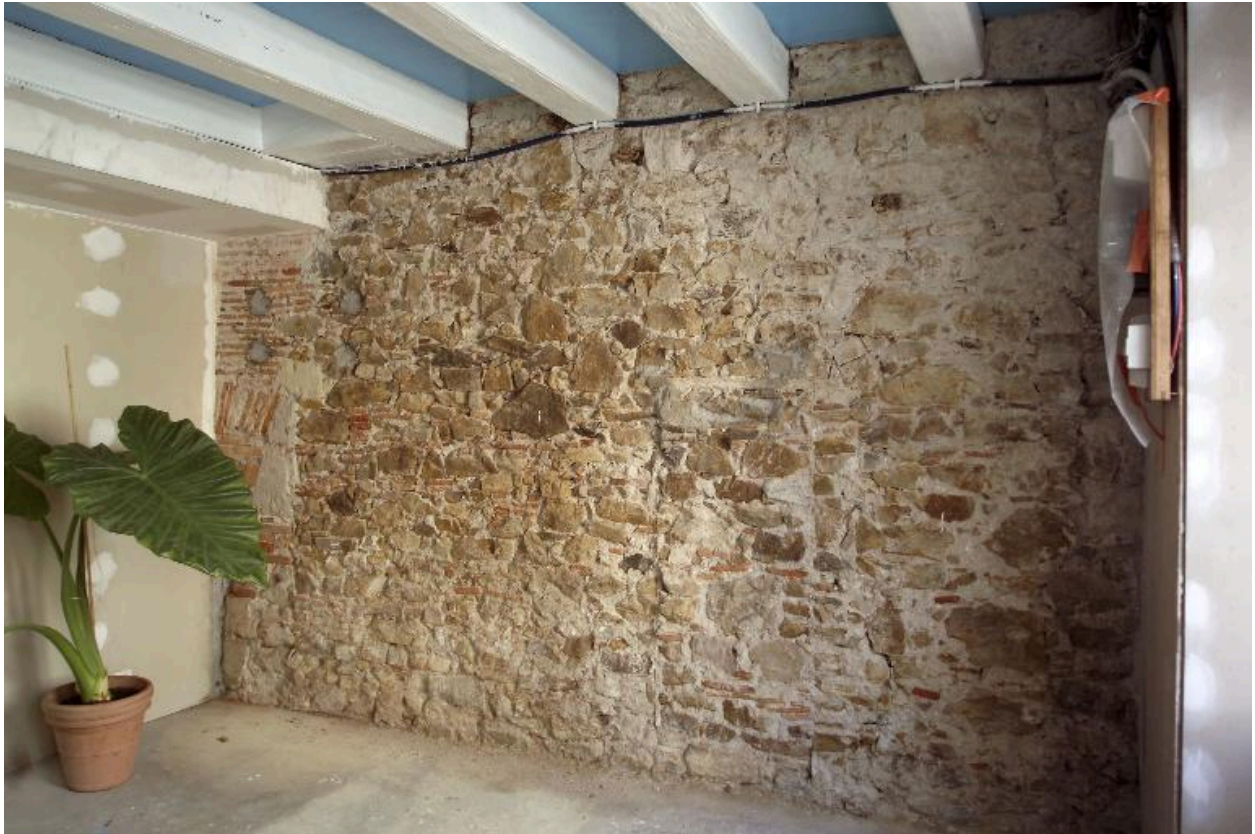
Le corps principal, le mur mitoyen à l'ouest au rez-de-chaussée.
