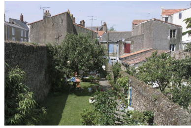
La façade postérieure de la maison n° 25 dans l'axe. Phot. Denis Pillet IVR52_20034400492NUCA
