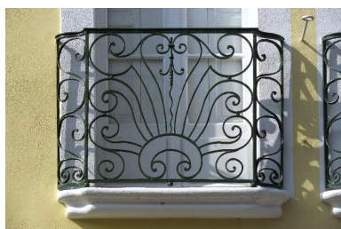
La façade sur la rue, détail du balcon d'une travée du premier étage. Phot. Denis Pillet IVR52_20034400386NUCA
