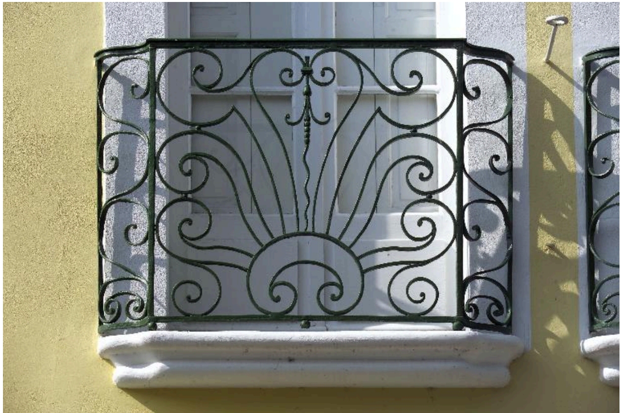
La façade sur la rue, détail du balcon d'une travée du premier étage.
