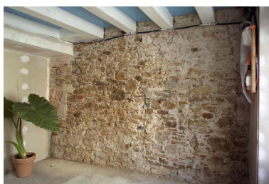
Le corps principal, le mur mitoyen à l'ouest au rez-de-chaussée. Phot. Denis Pillet IVR52_20034400484NUCA
