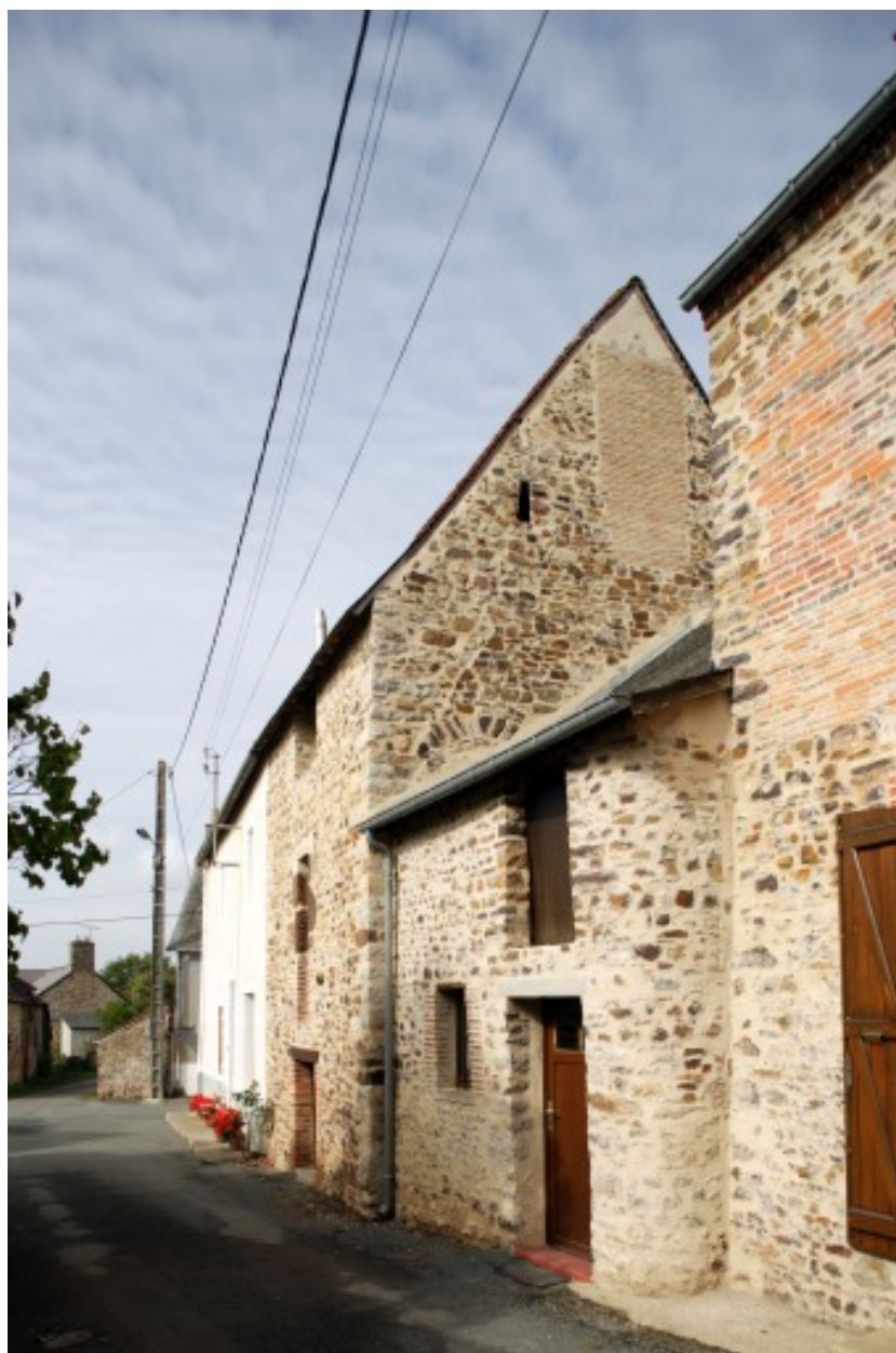
La façade sur rue du corps de bâtiment bas.
