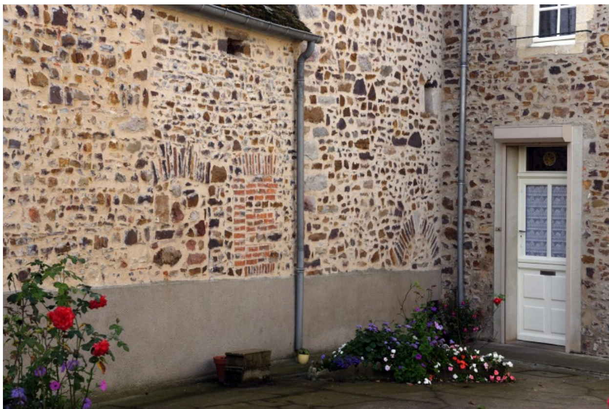
Détail de la façade sur cour du corps de bâtiment bas: à droite, les deux baies bouchées.
