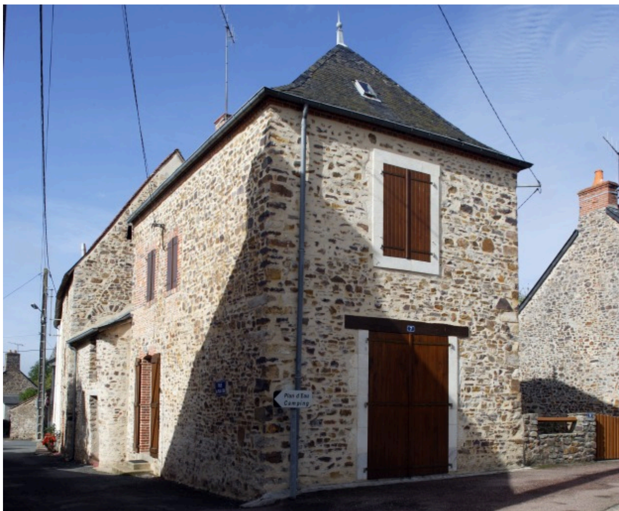
Les façades donnant sur la place et sur la rue du plan d'eau vues depuis la place.
