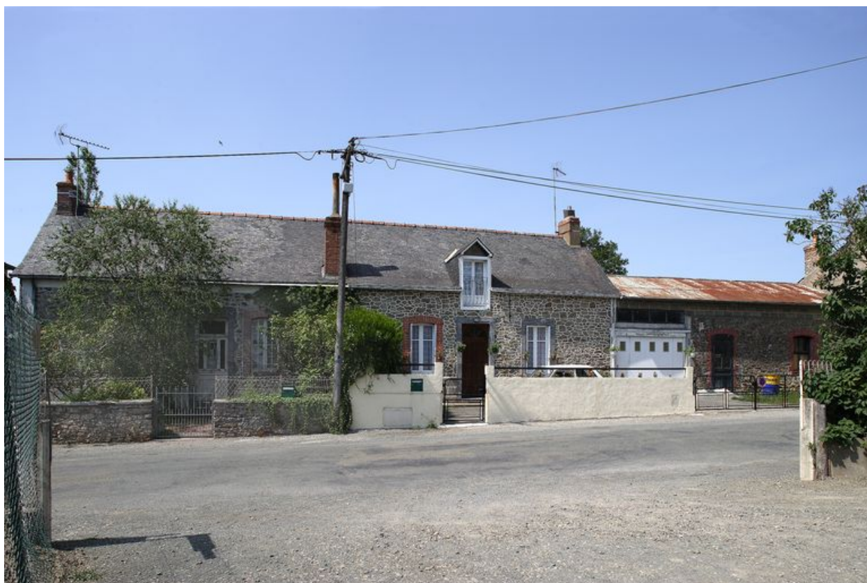
Vue depuis la rue. La maison et l'atelier sont à droite.
