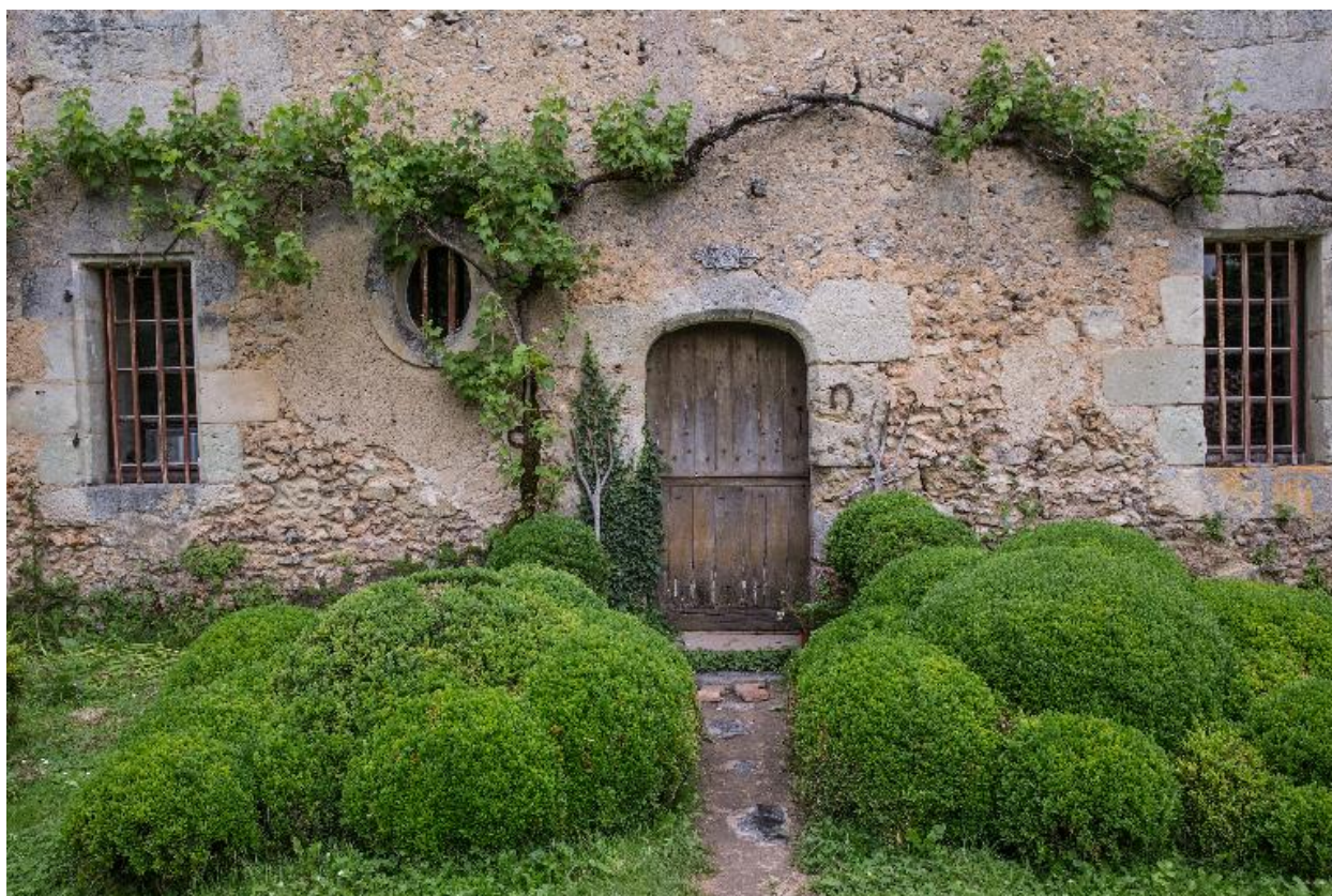
Logis, façade antérieure, rez-de-chaussée : détail des baies.
