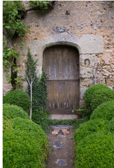
Logis, façade antérieure : porte. Phot. Pierre-Bernard Fourny IVR52_20187200850NUCA
