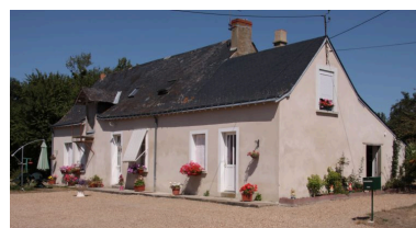
La maison et ses dépendances rénovées. Phot. Jean-Baptiste Darrasse IVR52_20097200448NUCA
