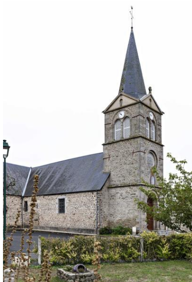
Eglise Saint-Martin de Thuboeuf, vue générale. Phot. Yves Guillotin IVR52_20205300259NUCA
