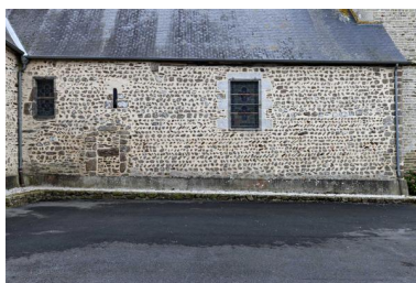
Bas-côté nord de l'église Saint-Martin de Thuboeuf. Phot. Yves Guillotin IVR52_20205300256NUCA
