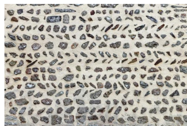
Maçonnerie en opus spicatum du bas-côté sud. Phot. Yves Guillotin IVR52_20205300258NUCA
