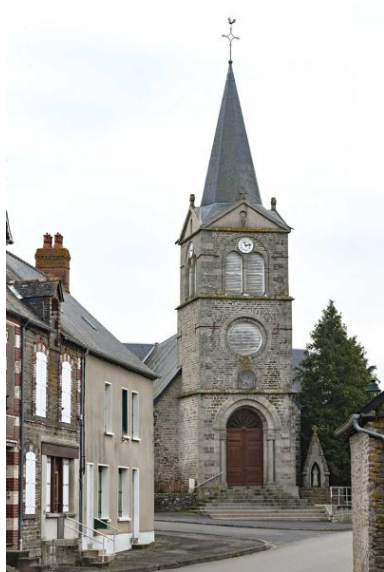
Tout-clocher. Phot. Yves Guillotin IVR52_20225300046NUCA
