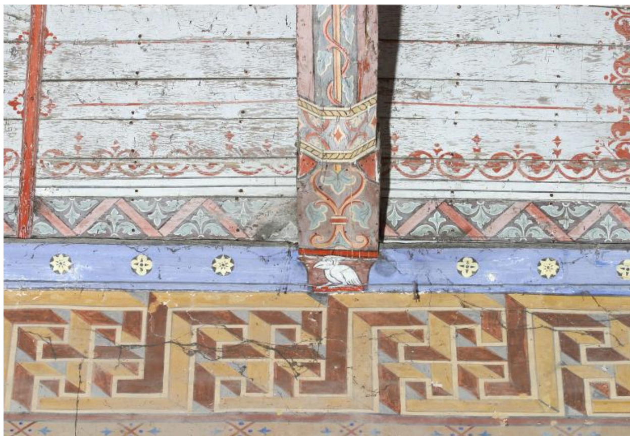
Nef, mur sud. Limite entre le mur et le lambris de couverture, détail au niveau de la cinquième ferme de la charpente.
