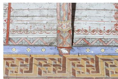
Nef, mur sud. Limite entre le mur et le lambris de couverture, détail au niveau de la cinquième ferme de la charpente.
