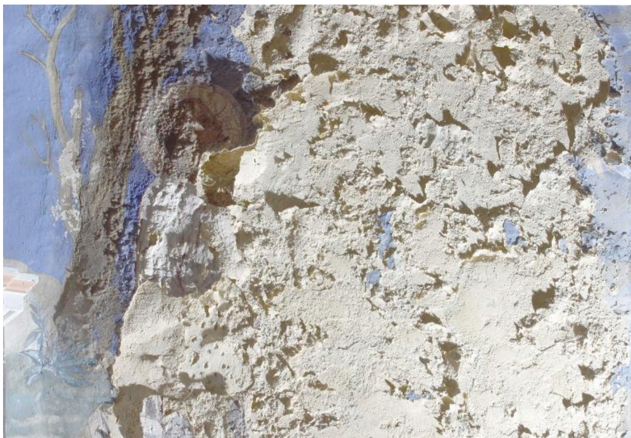
Avant chœur, mur sud. L'Agonie du Christ et saint Jean, détail d'une partie de la dégradation du support.
