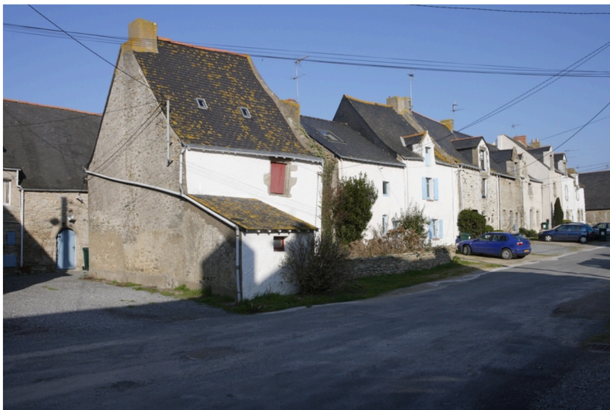
Vue d'ensemble de la rangée de maisons depuis le sud.
